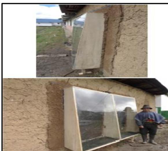
Finalizamos la construcción de la pared COB y el muro trombe, para luego realizar la instalación del sistema de calefacción solar en cada vivienda.
