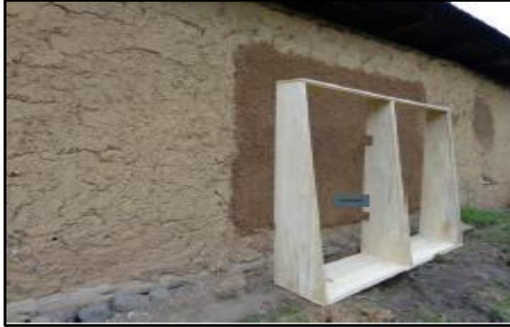
Ya anclada la estructura de madera en la pared COB ubicamos los puntos a perforar en los orificios con ayuda de dos herramientas un cincel y martillo. Estos orificios deben contar con un diámetro según lo estipulado en el capítulo 3.2.
