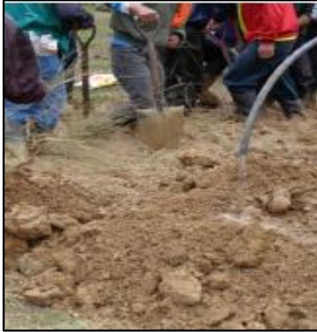
Procedemos al amasado del material para con ello continuar a la colocación del material en la pared COB.
