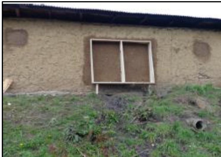
Después de anclar y perforar la estructura de madera, para evitar el desmoronamiento del COB se coloca un tubo en los orificios. Para evitar el paso de flujo se debe colocar una capa de COB esto alrededor de la estructura de madera y en los orificios.
