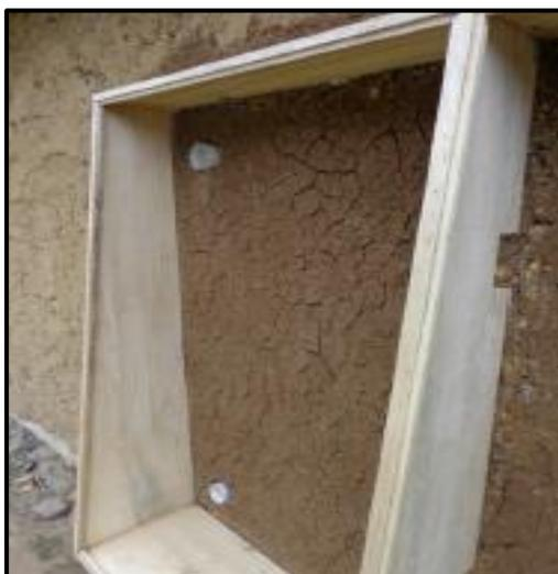
Se realiza una limpieza de pared, para luego pintar con látex de color negro. Y para culminar sería la colocación del vidrio y sellar aquellos bordes en general todos con silicona, pues así se busca no tener fugas de calor por el muro Trombe.
