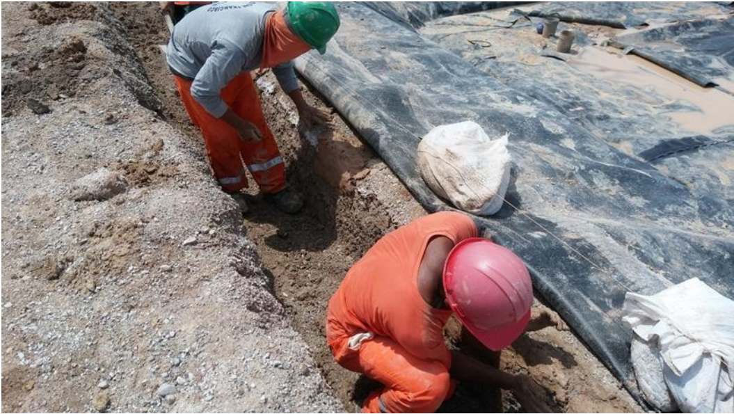
Foto 5. Instalación de Geomembrana.
