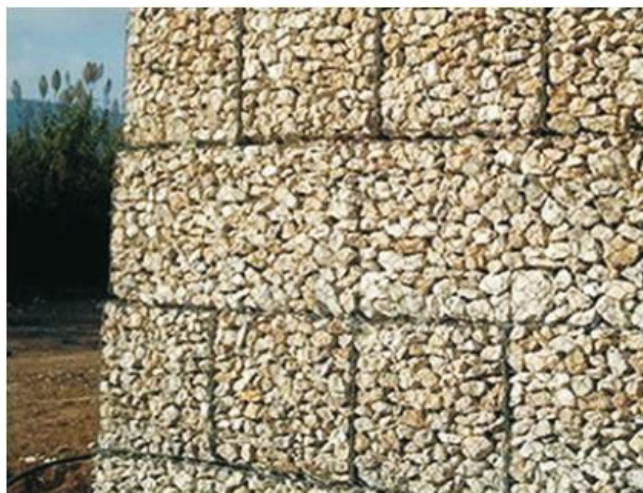
Figura 5. Muros de Contención Tipo Gaviones.
