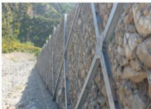
Figura 4. Muros de Contención Anclado Tipo Paragua.
