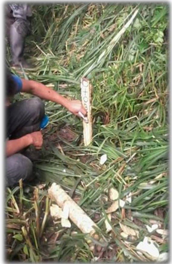
FOTO N°04: Estacado, Pintado y medición de progresivas a cada 20 metros.
