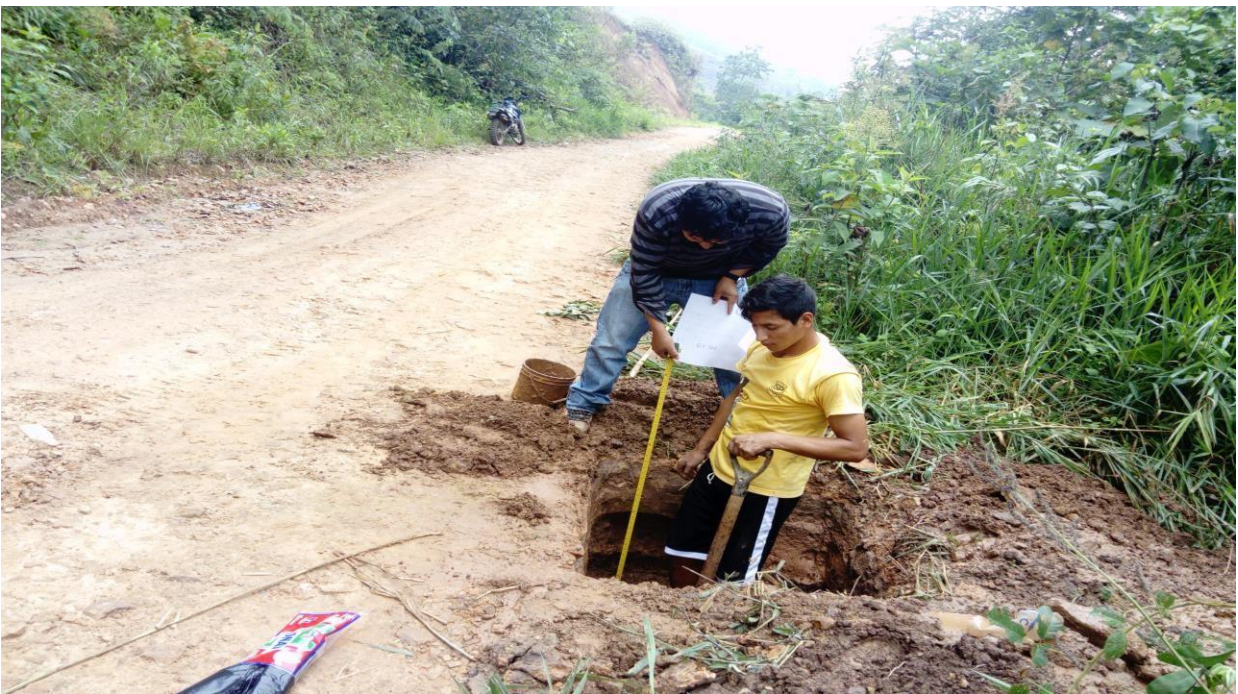
FOTO N° 02: verificando el desplante de la calicata.
