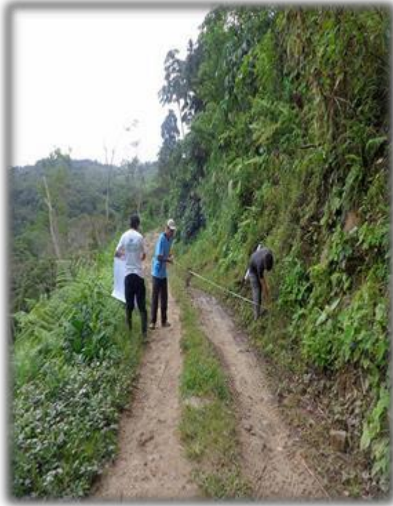
FOTO N°04: Estacado, Pintado y medición de progresivas a cada 20 metros.
