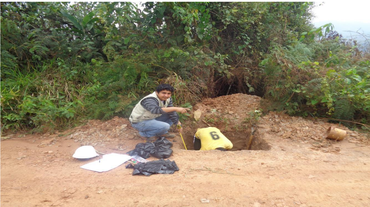
FOTO N° 04: realizando trabajos de extracción de muestras de calicatas para realizar los ensayos correspondientes.
