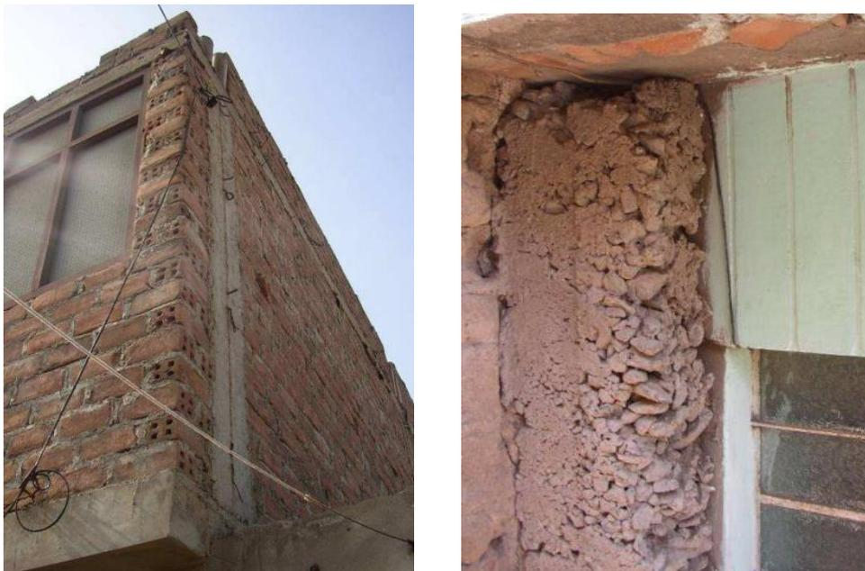
Figura 0-5: Ladrillos pandereta y concreto con cangrejas, típicas de viviendas autoconstruidas. Fuente: Laucata (2013).
