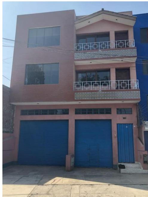
Figura 2-3: Edificaciones de tres niveles, autoconstruidas y de albañilería confinada, ubicadas en la Av. El Parral, Comas. Fuente: Elaboración propia.
