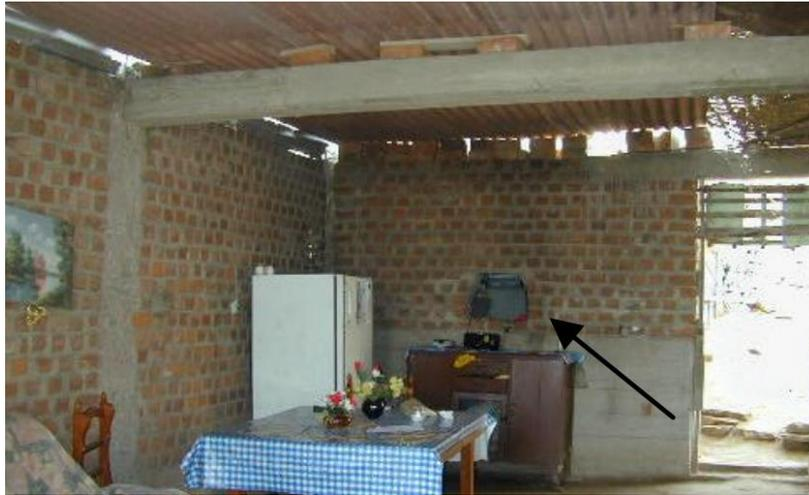
Figura 0-4: Viga colada in situ, sin losa aligerada. Fuente: Flores (2014).
