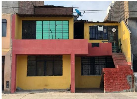
Figura 3-3: Vivienda autoconstruida de dos niveles de albañilería confinada, ubicada en la Av. El Parral, Comas. Fuente: Elaboración propia.
