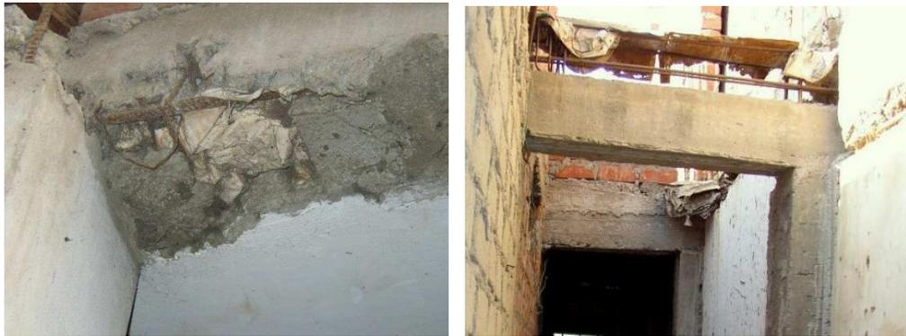
Figura 0-6: Recubrimiento del acero inexistente y exposición de acero estructural. Fuente: Laucata (2013).
