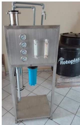
Figura 9. Estructura del proyecto ejecutado e instalado
