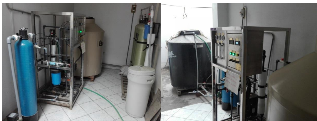
Figura 1. Ablandador de Agua usada para obtener el agua destilada
