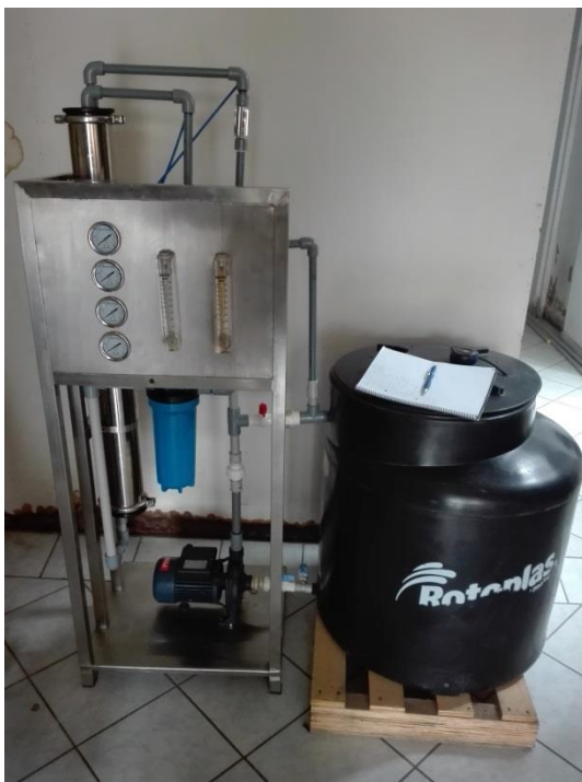
Figura 10. Estructura del proyecto ejecutado e instalado
