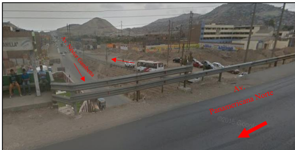
Ilustración 35. Vía expresa Panamericana Norte.
