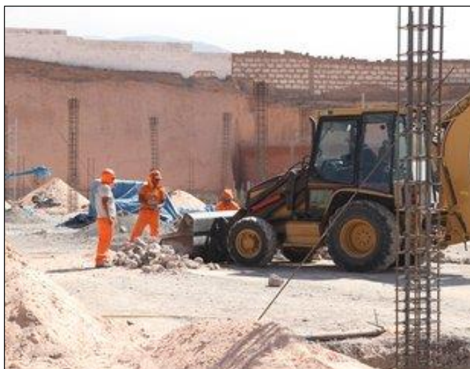
Ilustración 8 . Terreno de Plaza Norte en construcción.
