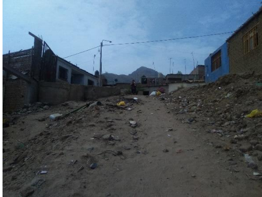
Figura N°47: Calle 19 con desnivel pronunciado.
