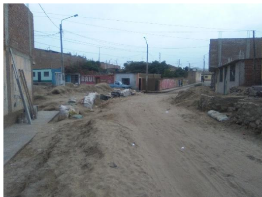
Figura N°34: Calle 12 con desmonte.
