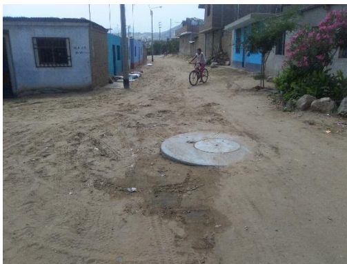
Figura N°56: Buzones existentes en Calle Los Laureles.
