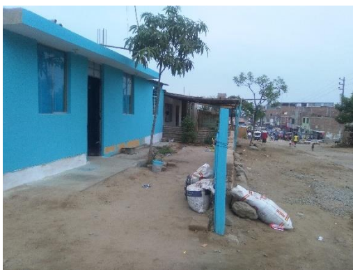
Figura N°51: Avenida 3 con cajas de saneamiento.
