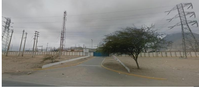
Figura N°9: Subestación Eléctrica HIDRANDINA S.A.
