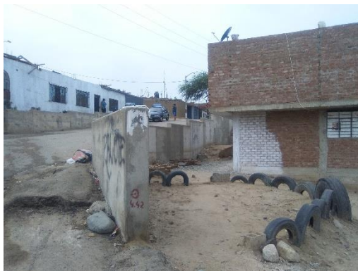
Figura N°45: Muros de contención existentes.
