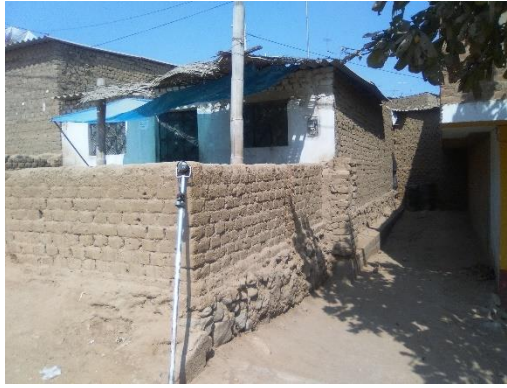
Figura N°43: Obstáculo de adobes en Avenida 4.
