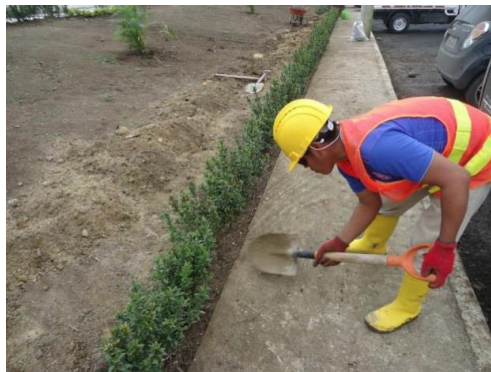
Figura N°132: Revegetación en áreas verdes de obra.
