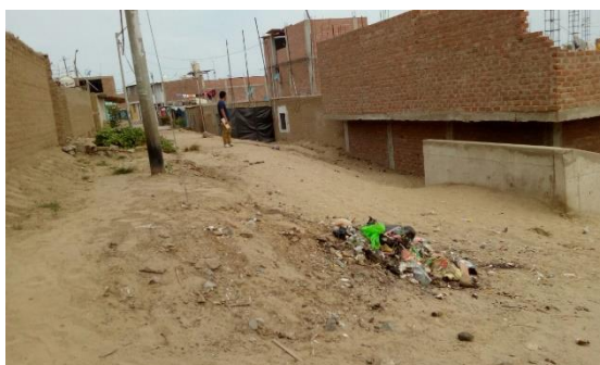
Figura N°49: Manzana "F" del Sector II, con muros de contención existentes.
