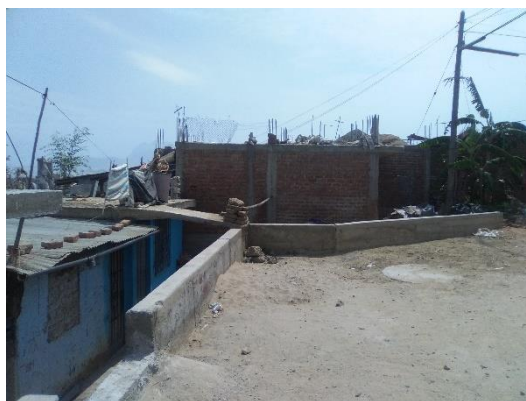
Figura N°50: Pasaje Los Laureles con muros de contención existentes.
