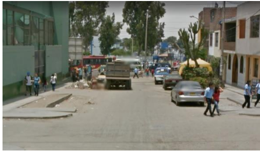
Figura N°129: Invasión de la faja de derecho de vía.
