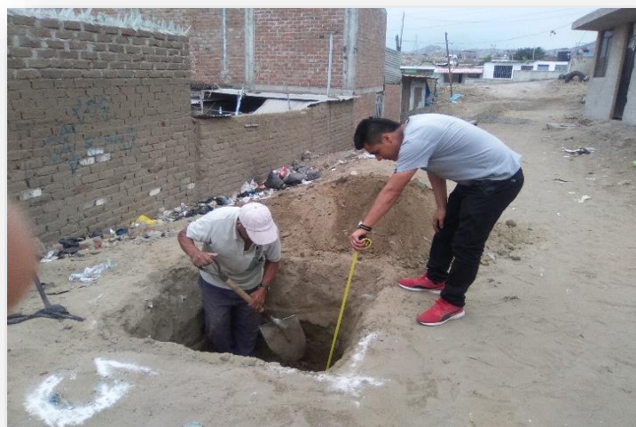
Foto N°140: Medición del fondo en la calicata N°1 en la Calle Los Laureles del Sector I.
