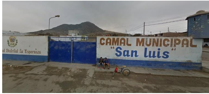
Figura N°26: Camal Municipal "San Luis".
