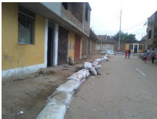
Figura N°52: Cajas de saneamiento y sacos de arena.
