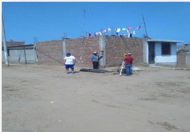
Foto N° 134. Visando puntos de vértices de manzanas.
