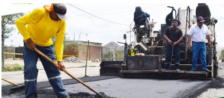
Figura N°128: Mano de obra.
