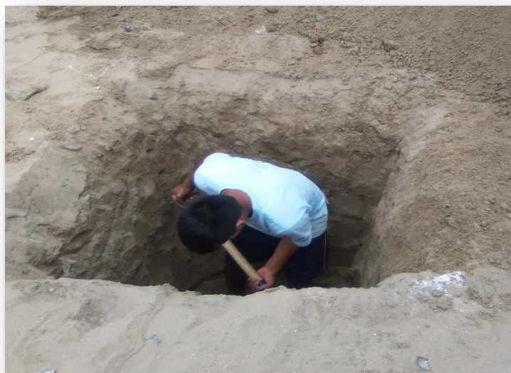
Foto N°139: Excavación de la calicata N°4 ubicado en la Calle 24 del Sector II, donde vemos el estrato del suelo (arena).
