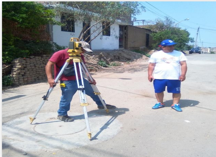
Foto N° 136. Haciendo una estación en el BM-11 por la Calle 21.
