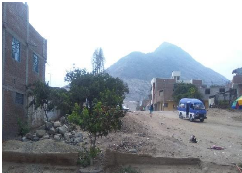
Figura N°37: Avenida 4 en terreno natural.
