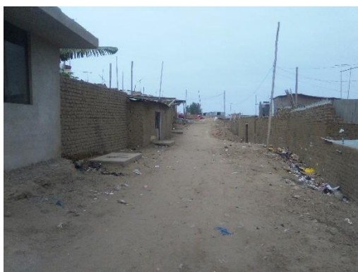
Figura N°53: Cajas de saneamiento en Calle Los Laureles.
