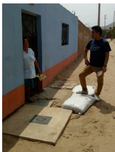
Figura N°55: Calle Los Laureles con cajas de saneamiento.
