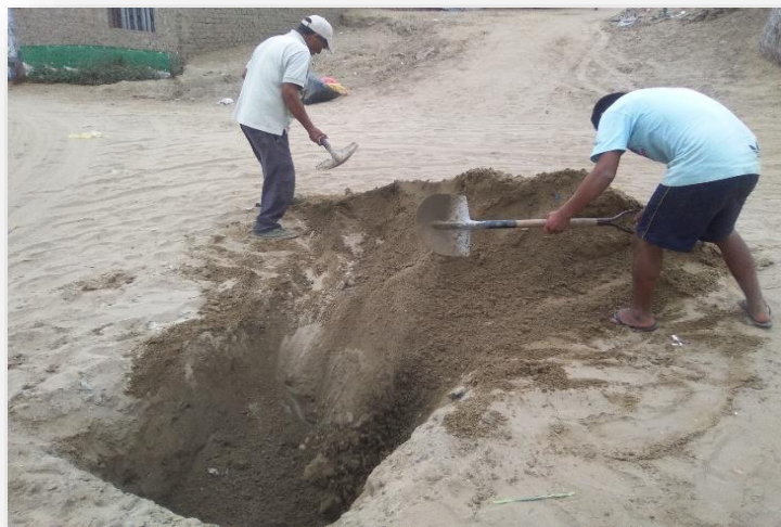
Foto N°142: Tapando la Calicata N°2 para la respectiva circulación en la zona.
