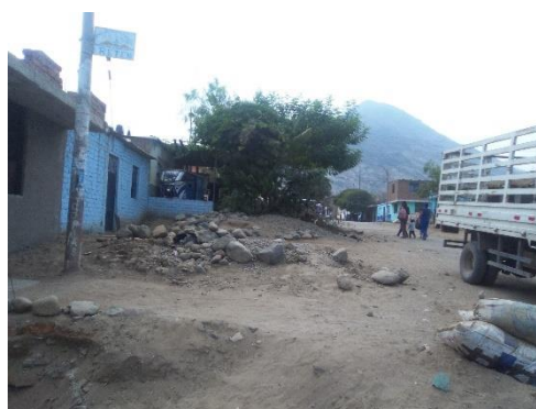
Figura N°36: Avenida 3 en mal estado.
