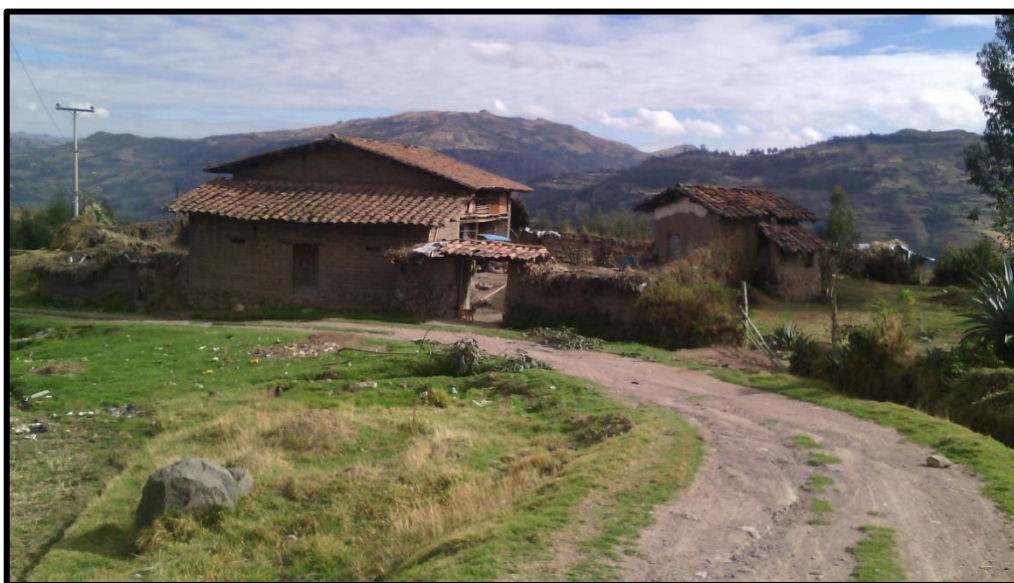
Imagen N° 9 : Ancho de la Via.
