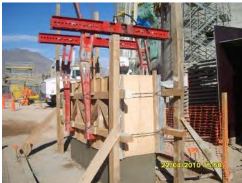
FIGURA I-8 “Se muestra una prueba del sistema para determinar la velocidad de fraguado”
