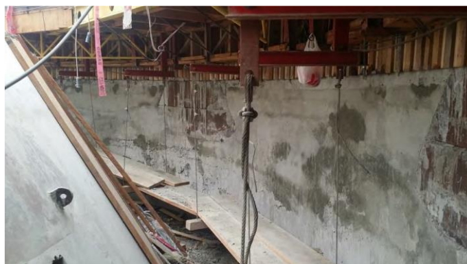
FIGURA I-70 “Armado de andamio inferior interior”.
