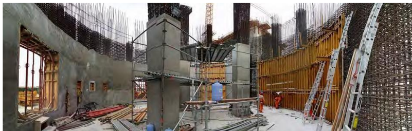
FIGURA I-4 “Toda la perspectiva que abarca con encofrado convencional de un almacén de concreto” .
