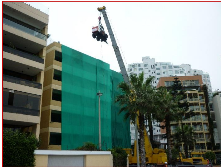
Figura 1: 16 Izaje de minicargadores
