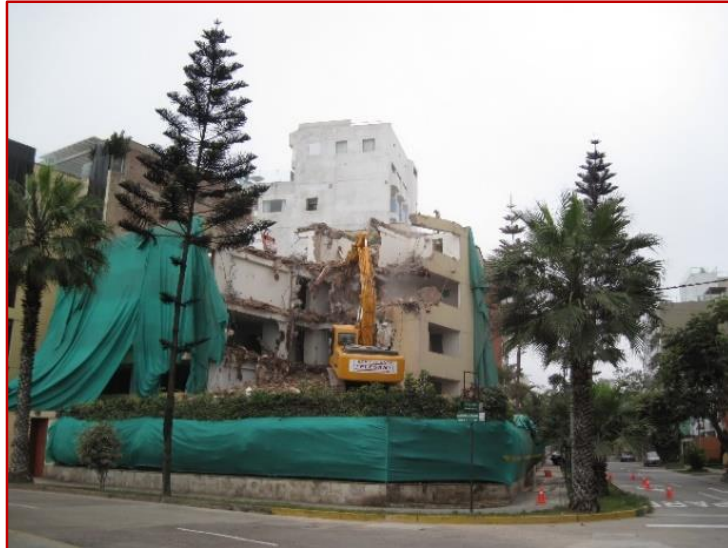
Fuente: Flesan del Perú SAC, 2014. Figura 1: 19 Demolición con excavadora standard
