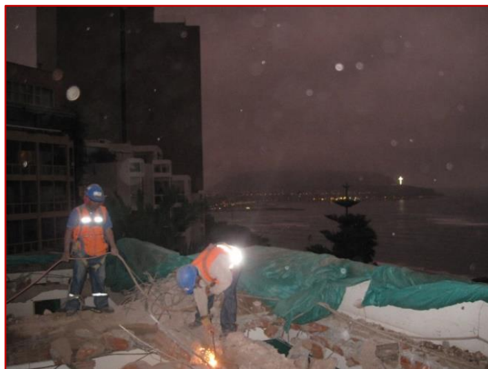
Figura 1: 17 Trabajos de oxicorte
