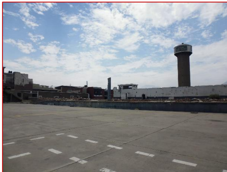
Figura 3: 10 Sector D - Edificaciones a nivel de piso
