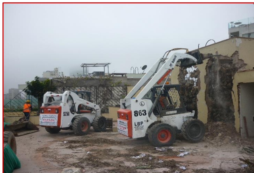
Figura 1: 10 Demolición con minicargadores con martillo
