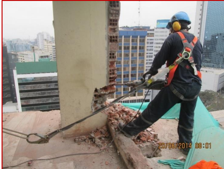
Figura 1: 12 Demolición con martillos eléctricos
