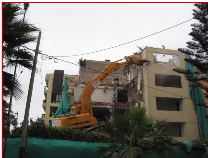
Figura 1: 6 Excavadora sobre oruga con cizalla
