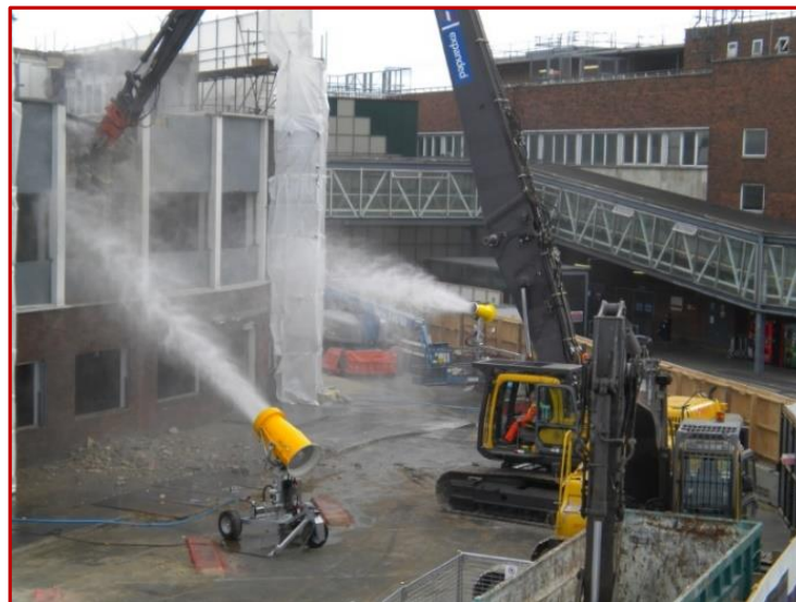
Figura 1: 14 Disipadores de polvo
