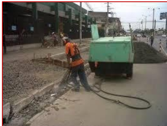
Figura 1: 13 Demolición con martillos neumáticos
