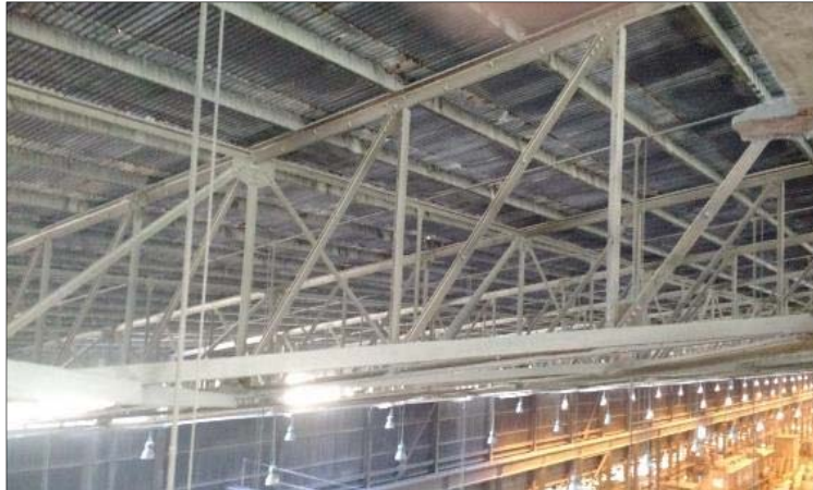
Cerchas y/o tijerales de techo (Fuente: Elaboración propia)
