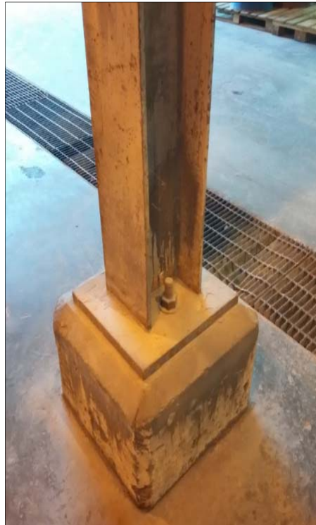
Columna y pedestal en Zona de Flotación (Fuente: Elaboración propia)
