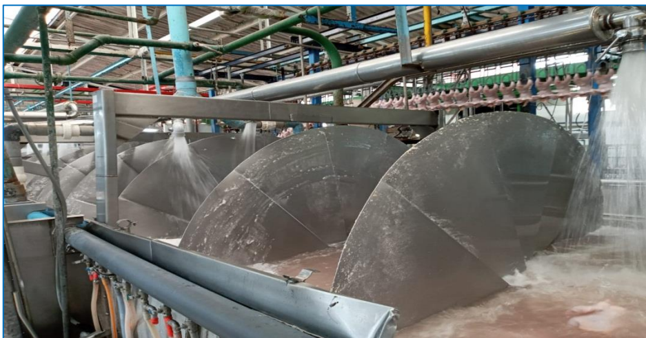
Figura. 19: Chiller Fuente: Elaboración propia.
