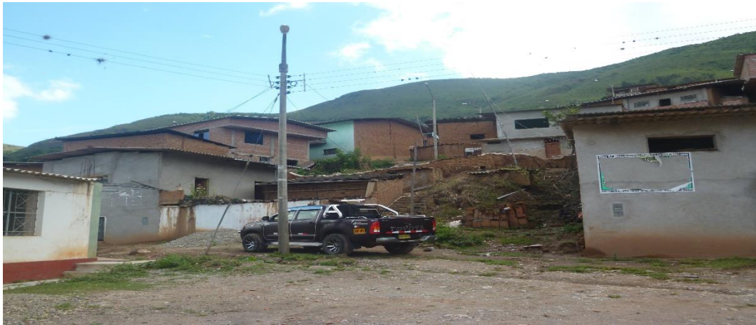
Sistema eléctrico en el Centro Poblado Huayobamba
