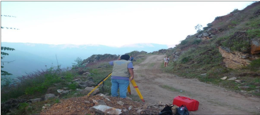
Levantamiento topográfico con estación total
