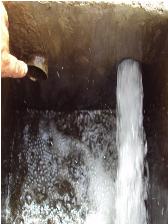
Funcionamiento de una sola ranura en la galería filtrante. (Fuente: autor)
