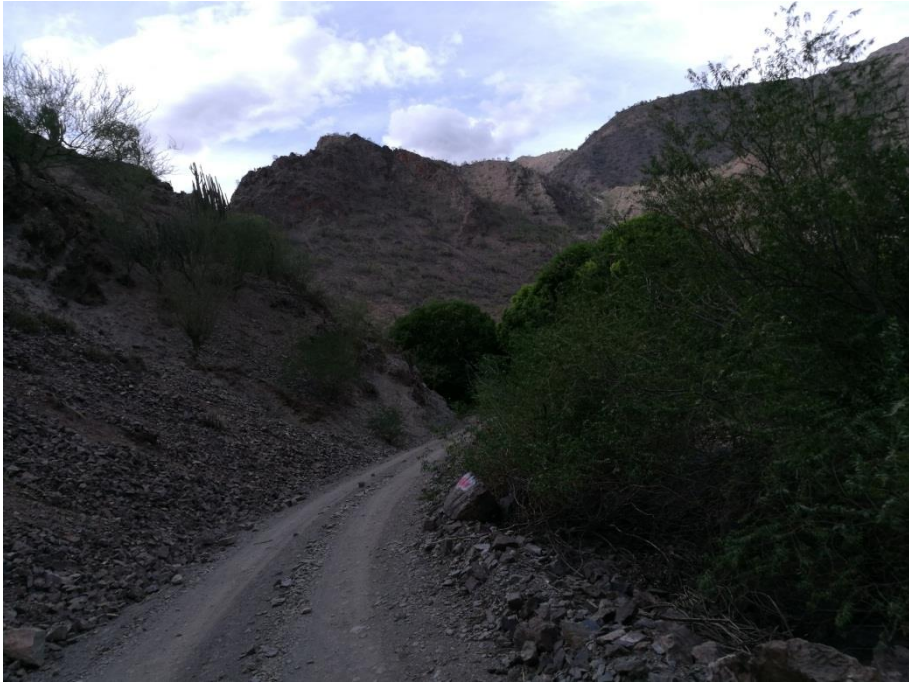
Fotografía 07: Talud inestables con material suelto
