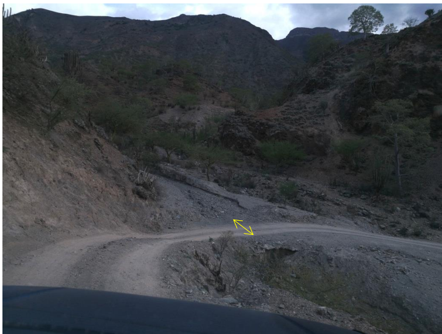
Fotografía 03: Sección irregular y reducida (ancho 3 m)
