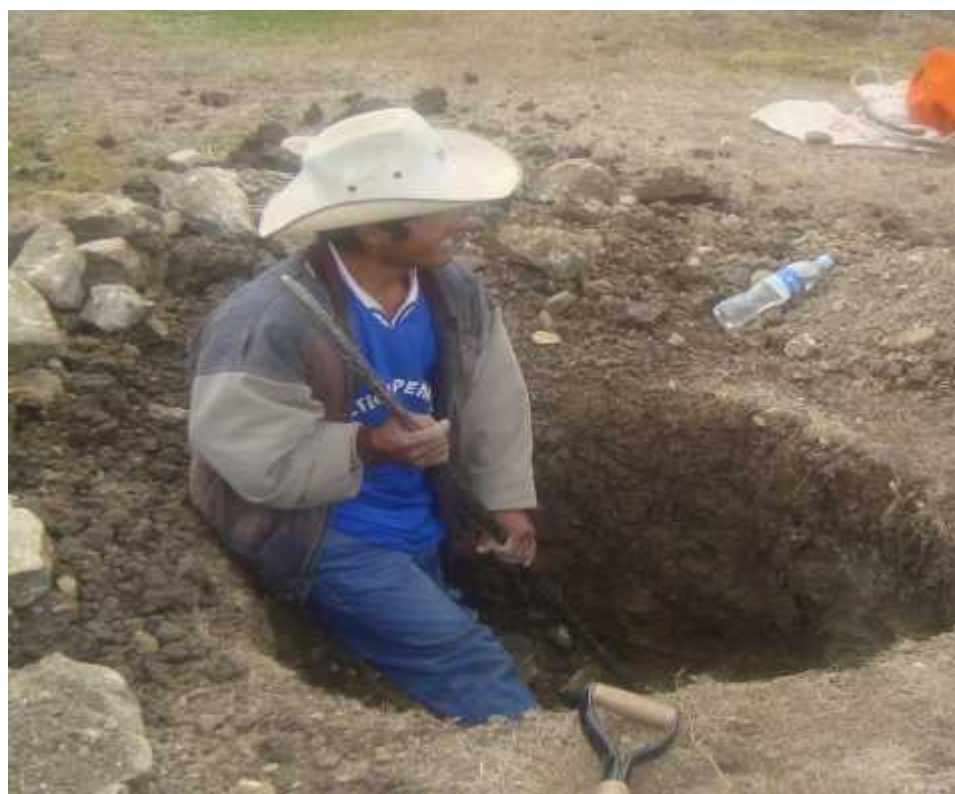
FOTO N° 06: EXCAVACION DE CALICATA
