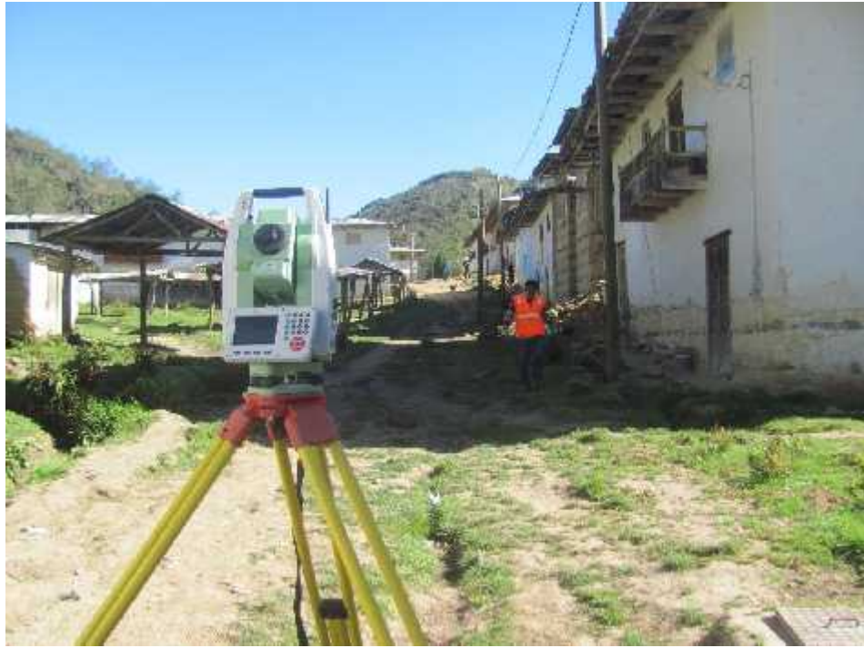
FOTO N° 01: INICIANDO LEVANTAMIENTO – LOCALIDAD ANDAMACHAY
