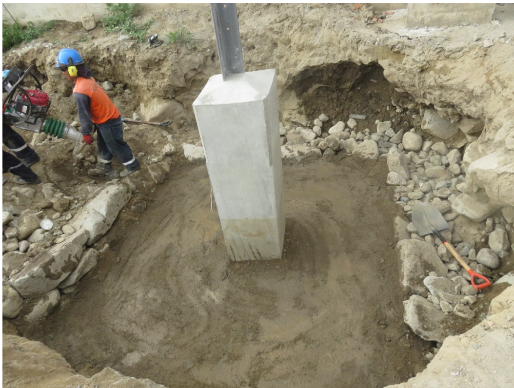
Figura 39: Compactado de la cimentación
