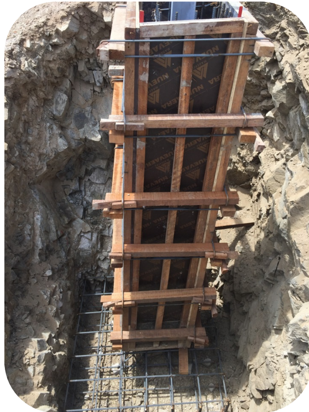
Figura 3: Colocación de acero refuerzo en la cimentación para torres autosportadas Fuente: Propia
