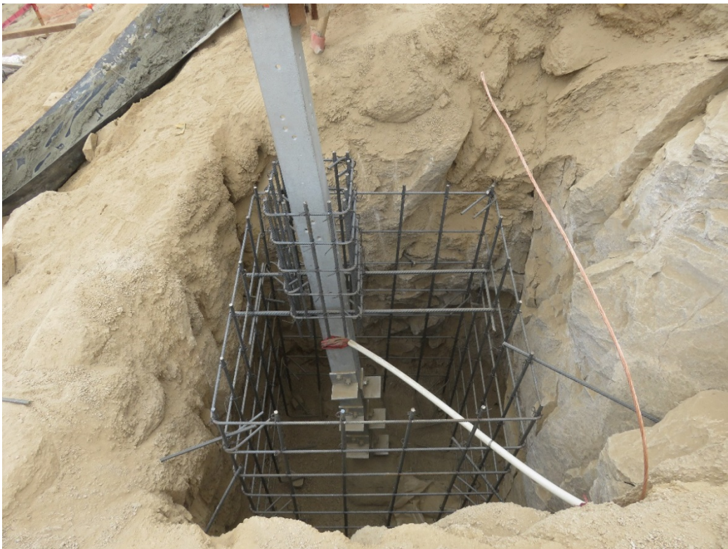
Figura 35: Presenciando la colocación de acero refuerzo.
