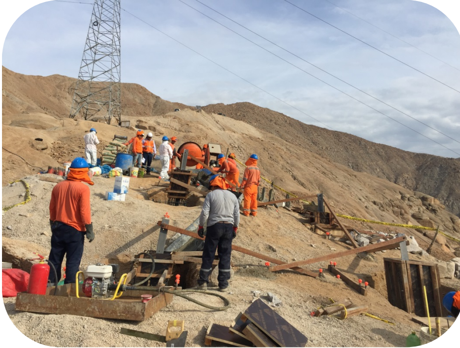
Figura 4: Colocación de concreto 210kg/cm 2 en cimentaciones Fuente: Propia
