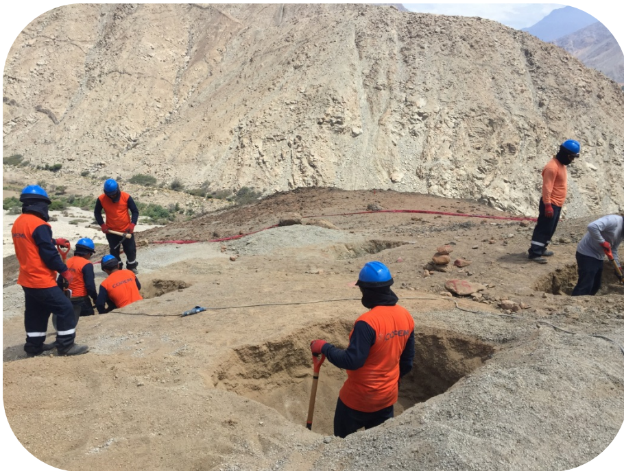
Figura 2: Excavación manual y con roto martillo eléctrico Fuente: Propia
