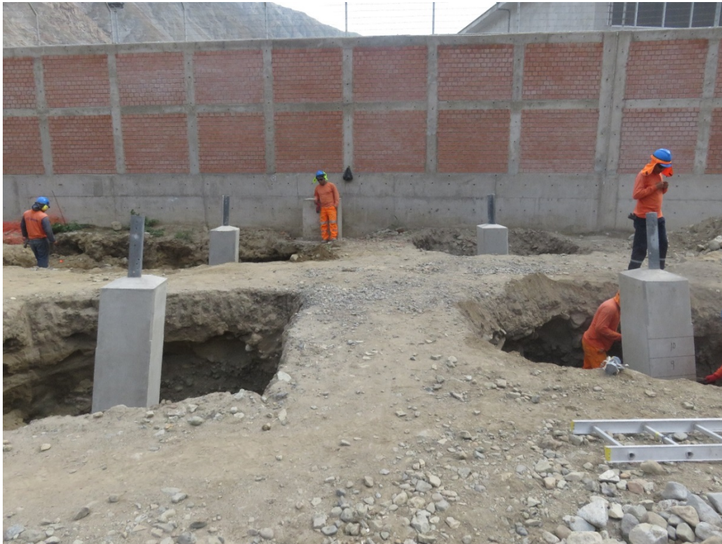
Figura 38: Cimentación terminada
