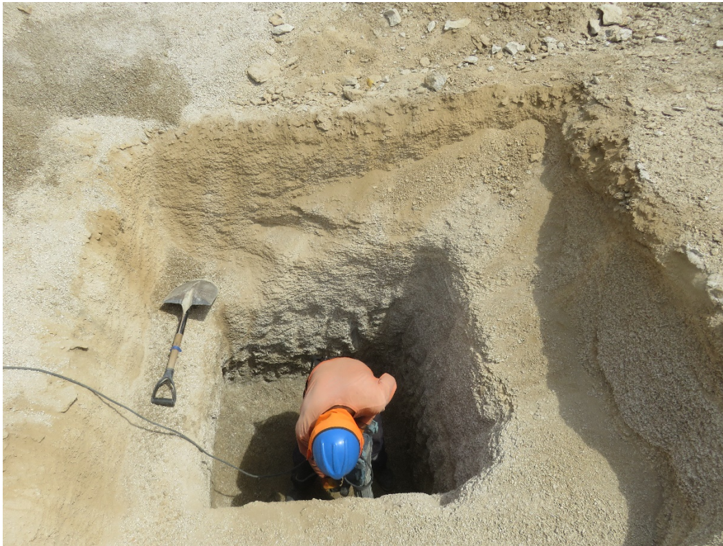
Figura 34: Presenciando la Excavación
