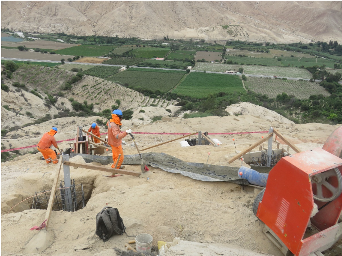
Figura 36: Presenciando la colocación del concreto para cimentación
