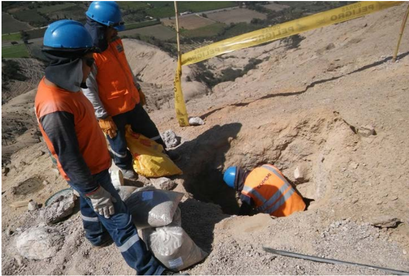
Figura 13: Sondajes geotécnicos directos - calicatas Fuente: Estudio de mecánica de suelos para la línea de transmisión 66kV.
