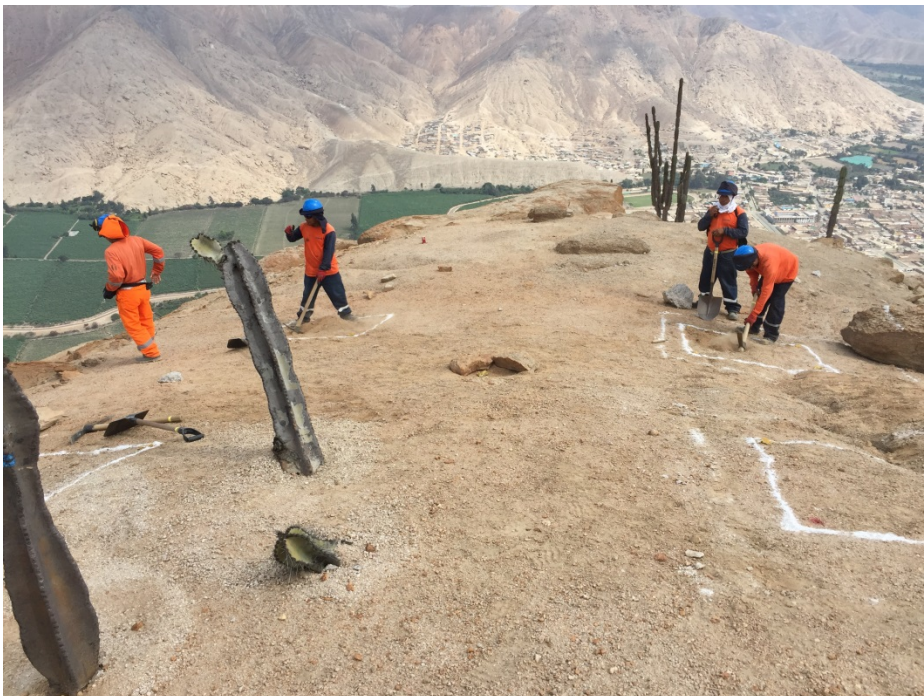
Figura 11: Partida de excavaciones con ruta crítica Fuente: Propia
