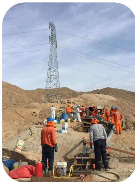
Figura 23: Vaciado de concreto 210kg/cm 2 . Fuente: Propia
