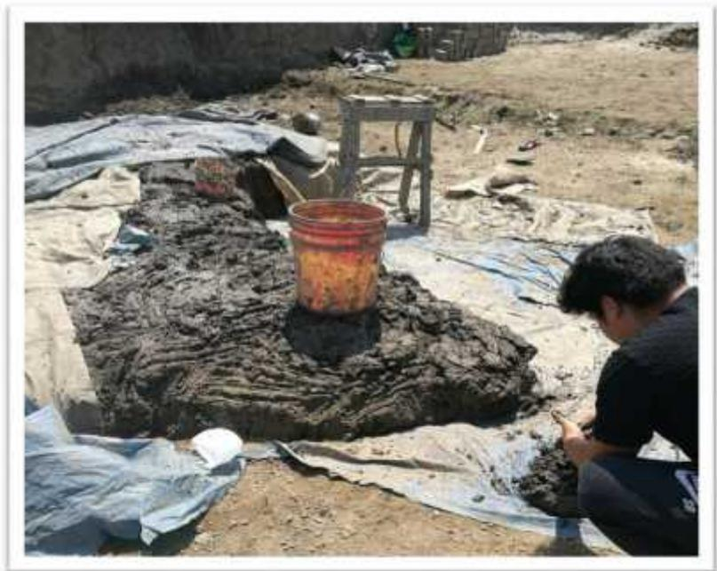
Figura N° 16: Elaboración manual de bloques de adobes estabilizados artesanales
