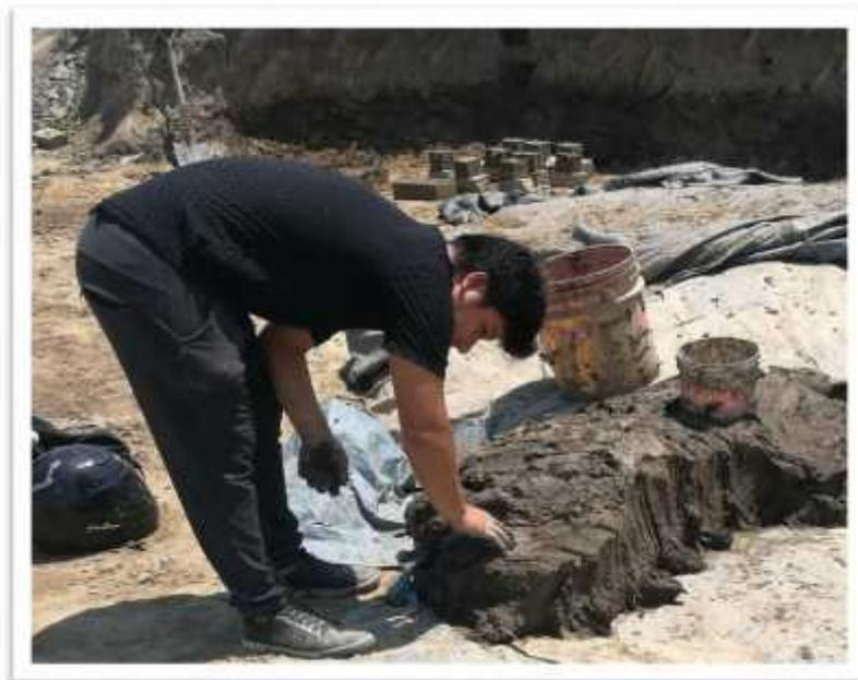
Figura N° 15: Humedecer la tierra extraída de la cantera “La Llave” - Santa
