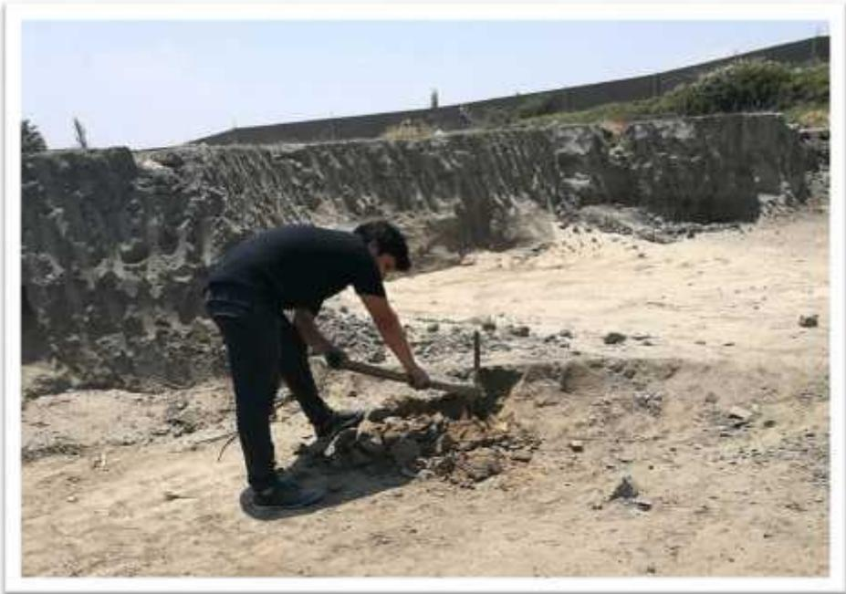
Figura N° 02: Extracción de tierra para elaboración de bloques de adobe estabilizado
