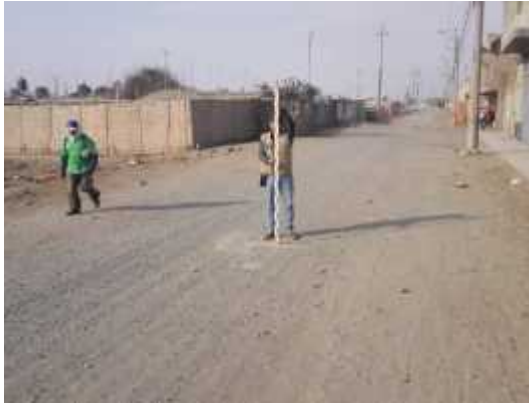
Figura 9: Se realizó el levantamiento topográfico de la red de alcantarillado.
