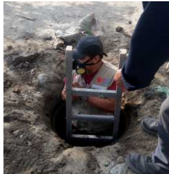
Figura 13: Se realizó el ingreso a los buzones para medir los niveles de sedimentación.
