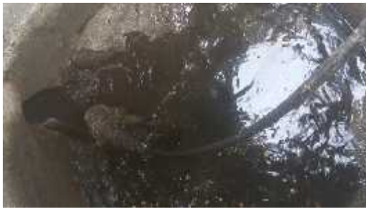
Figura 19: Al retirar la varilla de acero, se produjo un aumento del caudal y por poco se rebalsa.
