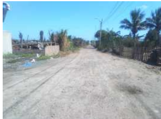
Figura 8: Se aprecia en la imagen la parte final del Pasaje Los Jardines el cual evacua las aguas residuales al Buzón de Empalme.
