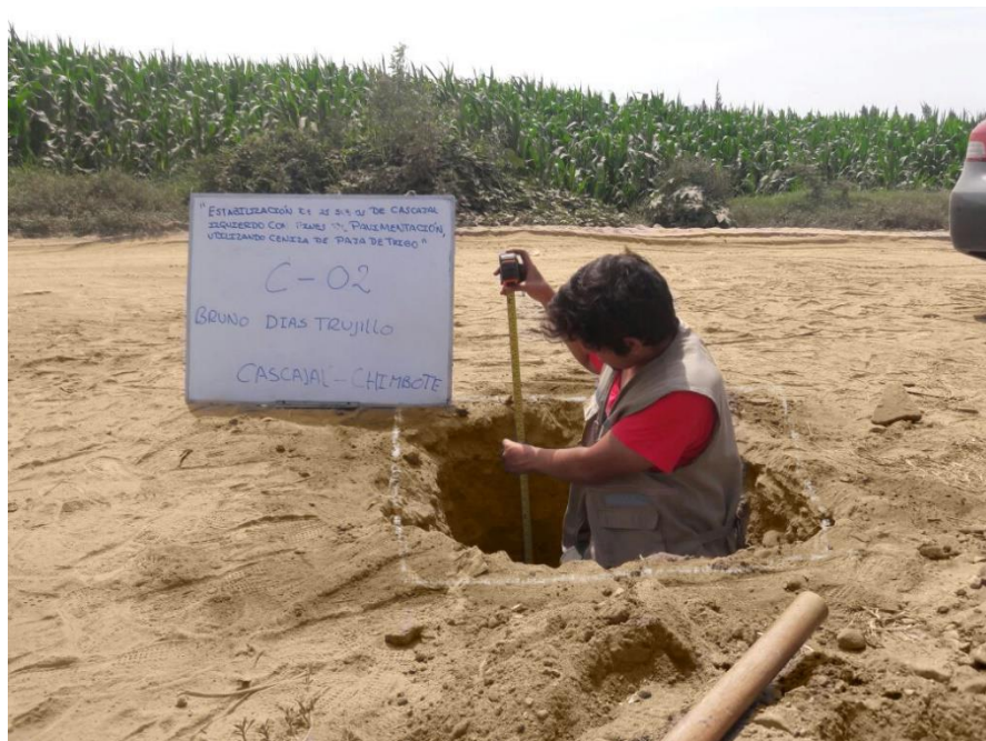
Foto N°4: Calicata N°02 en la progresiva 0+485m en Cascajal Izquierdo.
