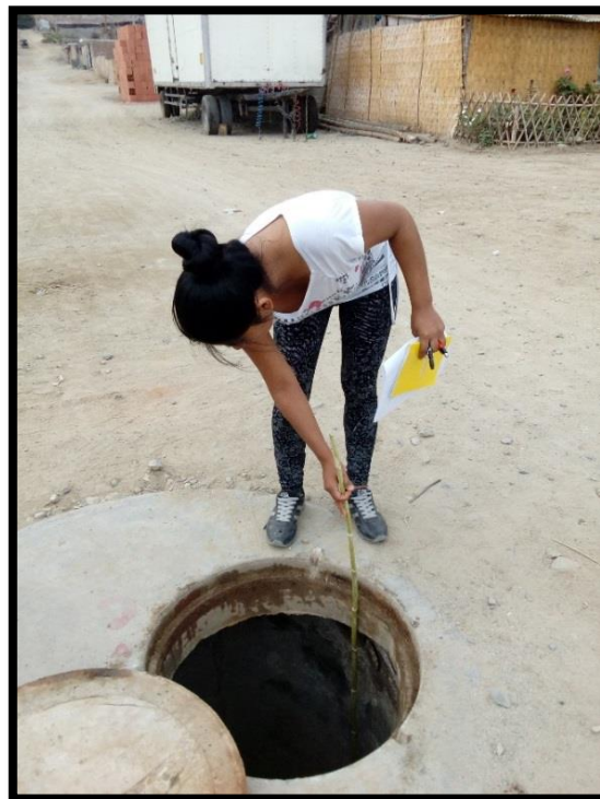
Ilustración 8: Buzones de inspección
