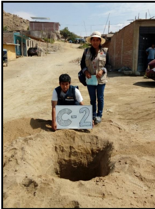
Fuente: Autor en la elaboración de calicatas
