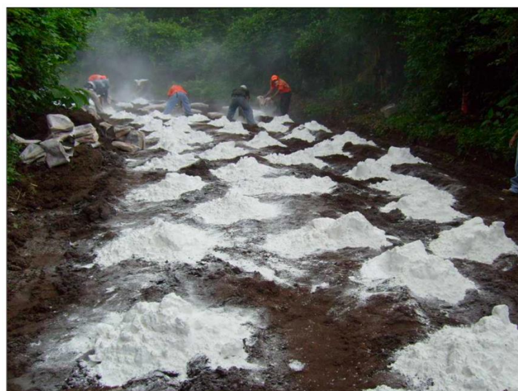
Figura 17: Apertura de sacos de cal hidratada. Fuente: Sampedro.
