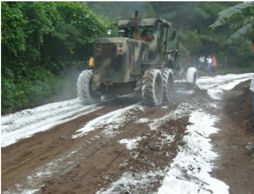
Figura 4: Aplicación de la cal hidratada a la subrogante. Fuente: Sampedro
