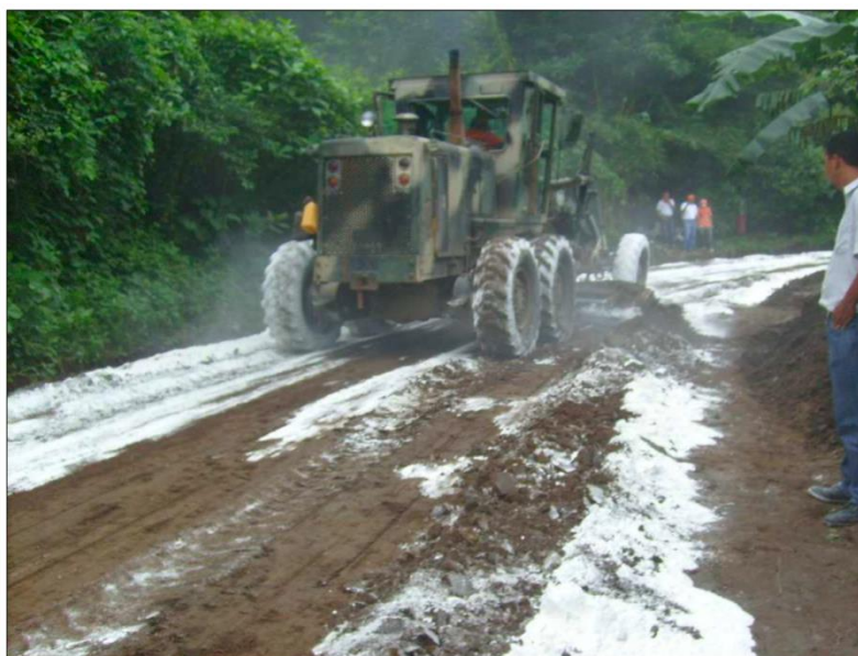
Figura 18: Mezclado de cal hidratada por medio de maquinarias. Fuente: Sampedro.
