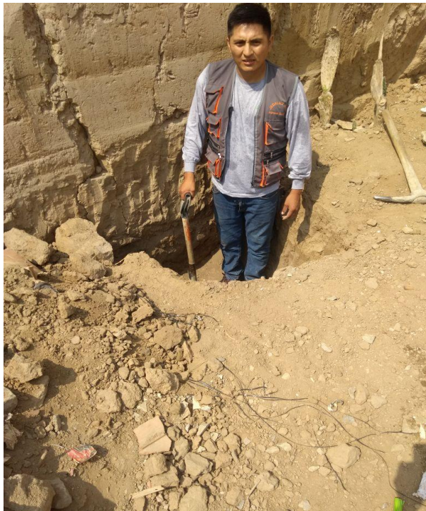
Figura 46: Calicata terminada. Fuente: Elaboración propia.
