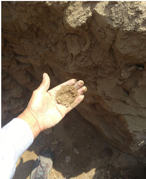
Figura 45: Suelo amarillento con de material limo y un poco de arcilla. Fuente: Elaboración propia.
