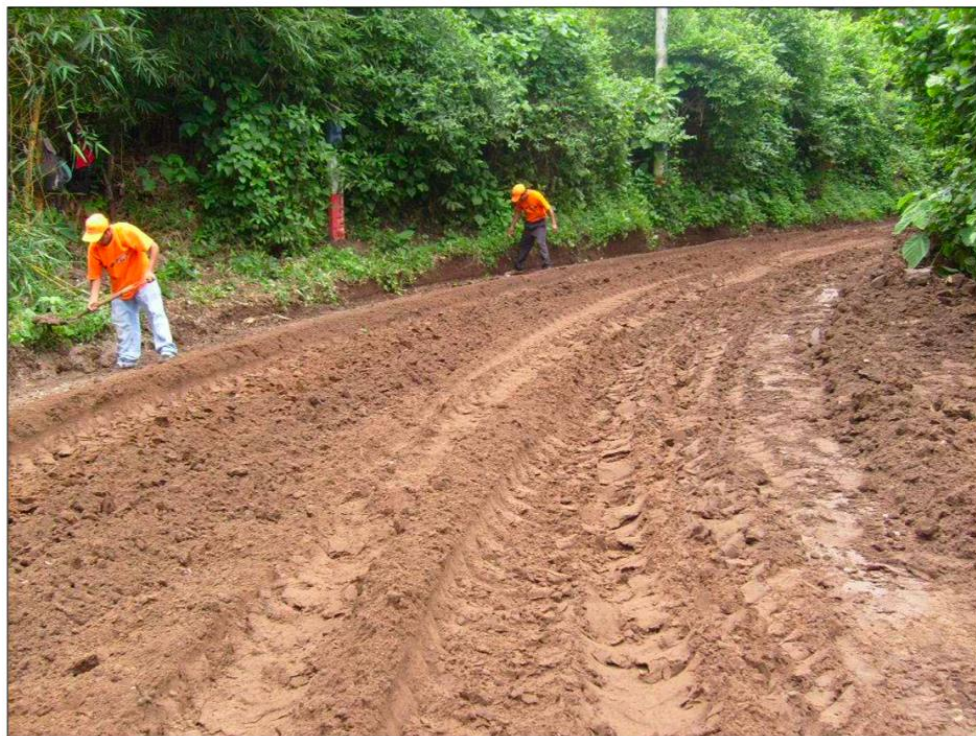
Figura 15: Movimiento de tierras. Fuente: Sampetro.
