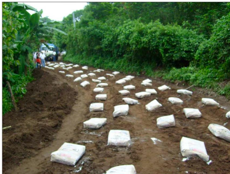
Figura 16: Distribución de sacos de cal hidratada. Fuente: Sampedro.
