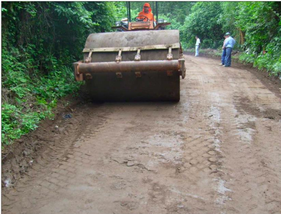
Figura 19: Compactación de suelo estabilizado. Fuente: Sampedro.
