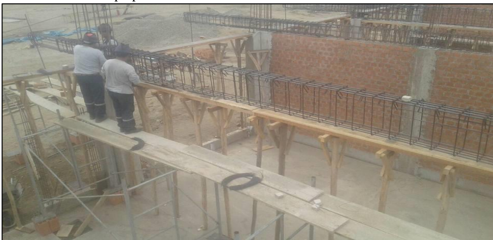
Figura 25. Habilitación de acero para vigas.
