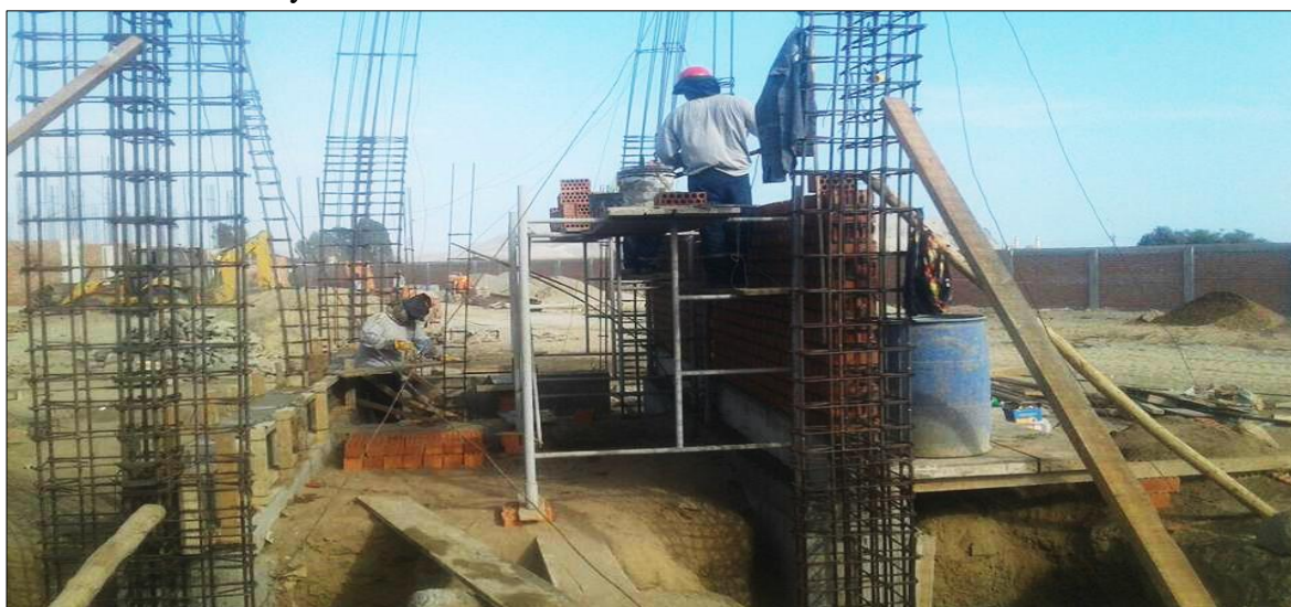
Figura 19. Asentado de ladrillo.
