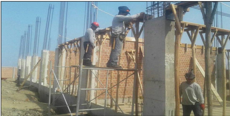
Figura 24. Encofrado de viga.
