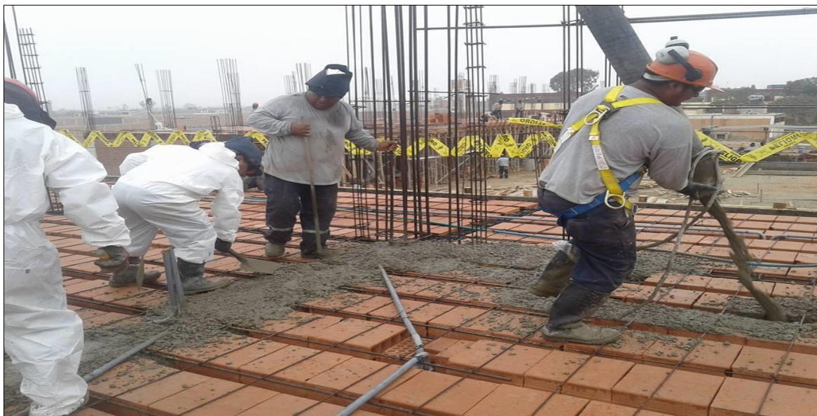
Figura 18. Vaciado de concreto de loza.
