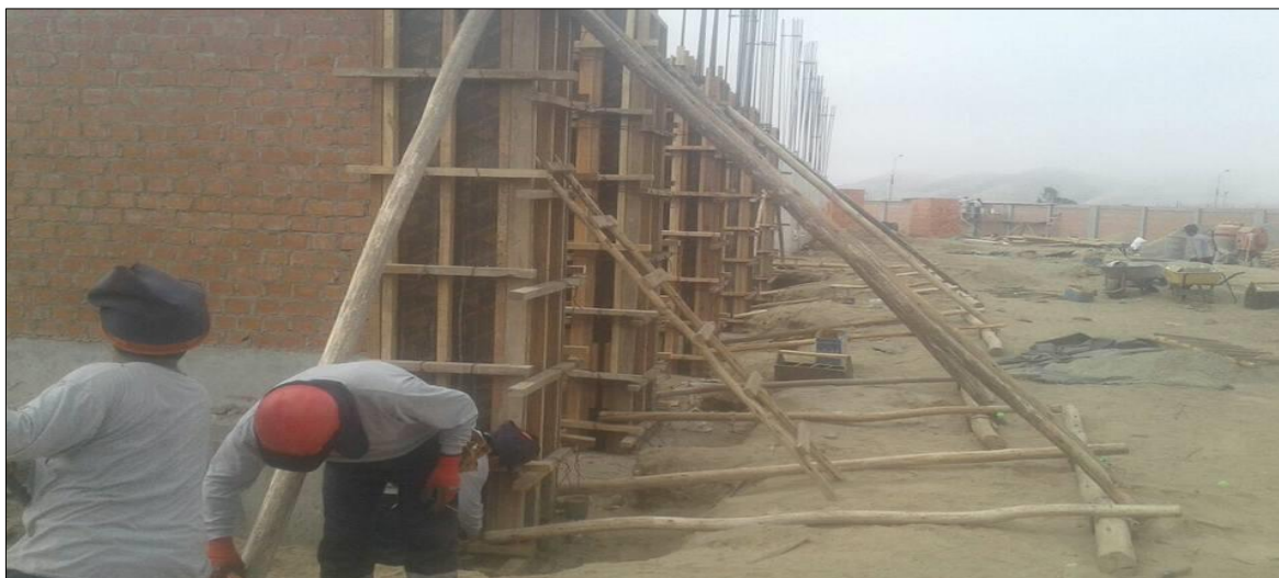
Figura 15. Encofrado de columnas.
