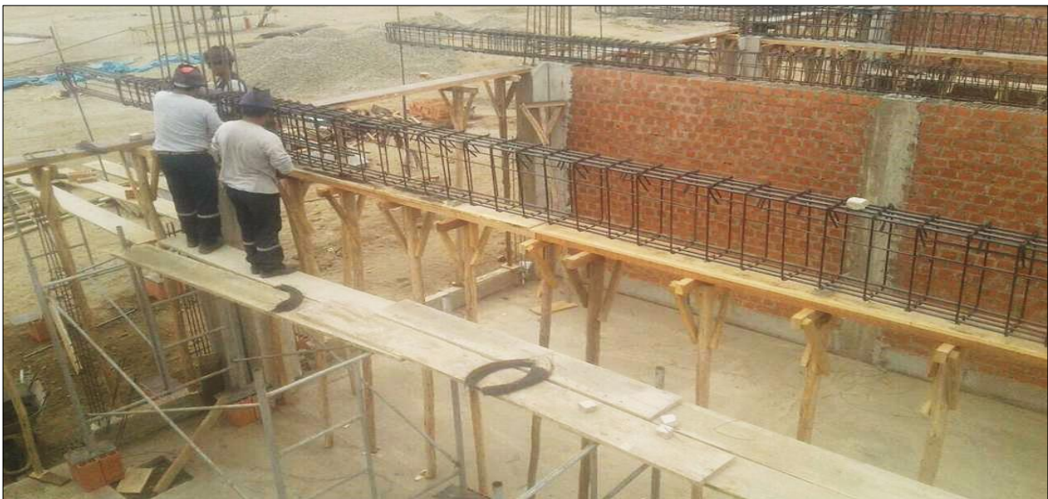
Figura 16. Habilitación de acero.
