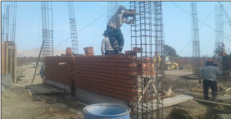
Figura 23. Asentado de ladrillo.
