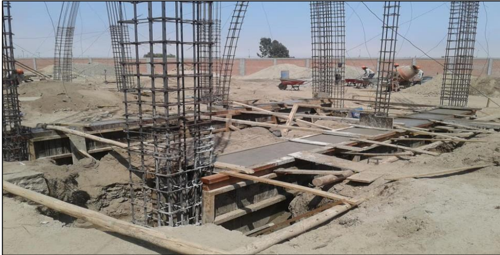
Figura 27. Vaciado de concreto.
