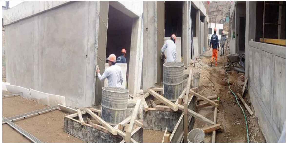
Figura 17. Tarrajeo de muros interiores.
