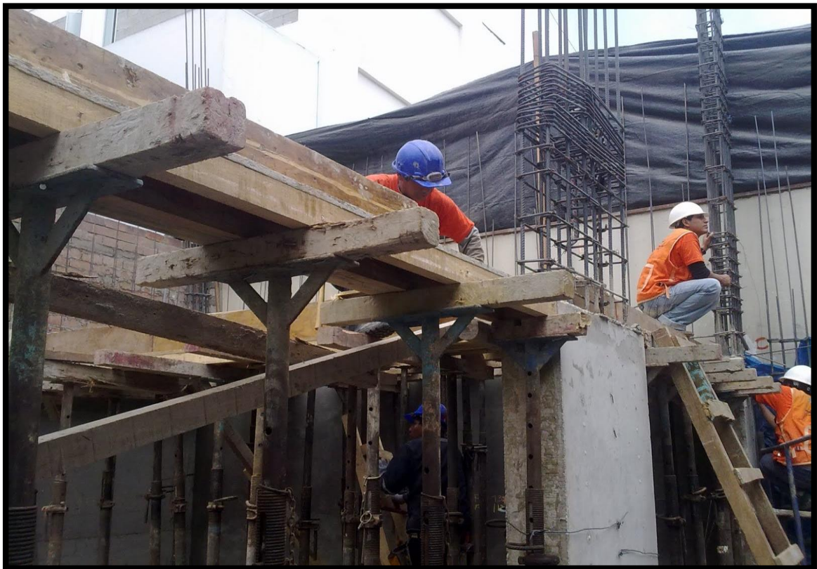
Figura 16. Desencofrado de columna. Fuente: Elaboración propia
