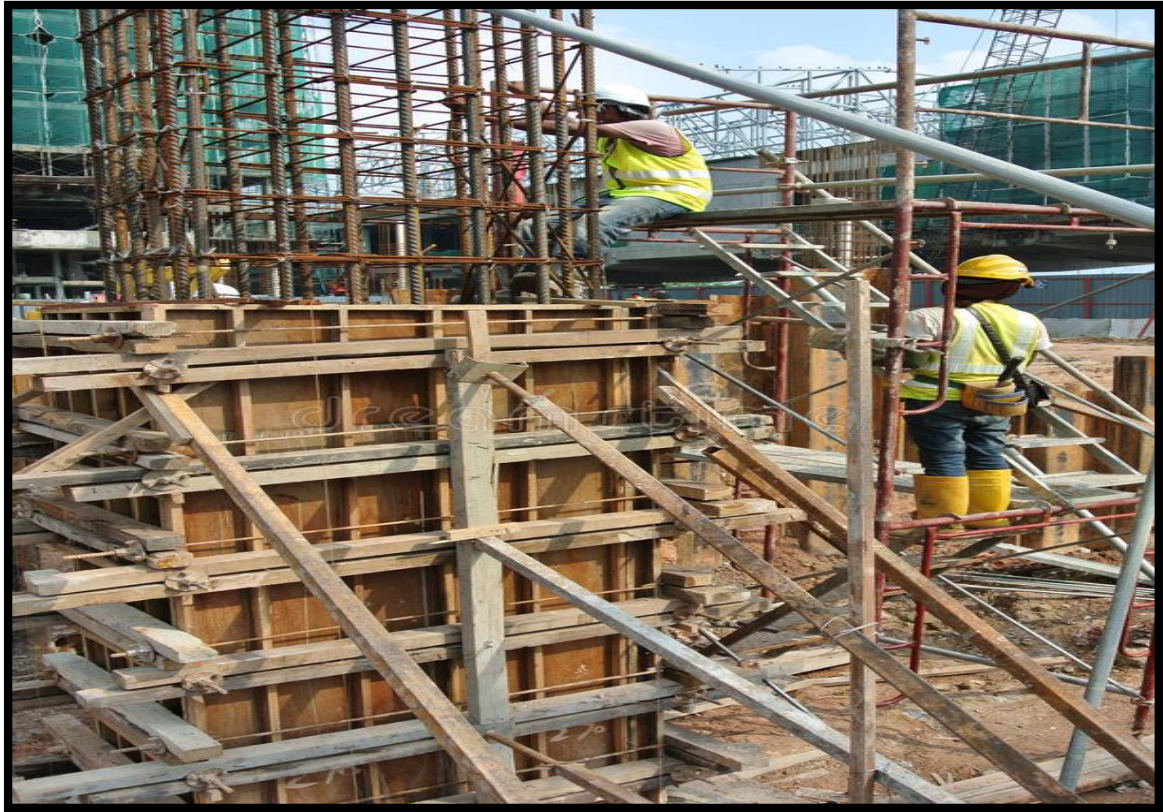
Figura 15. Encofrado de columna. Fuente: Elaboración propia
