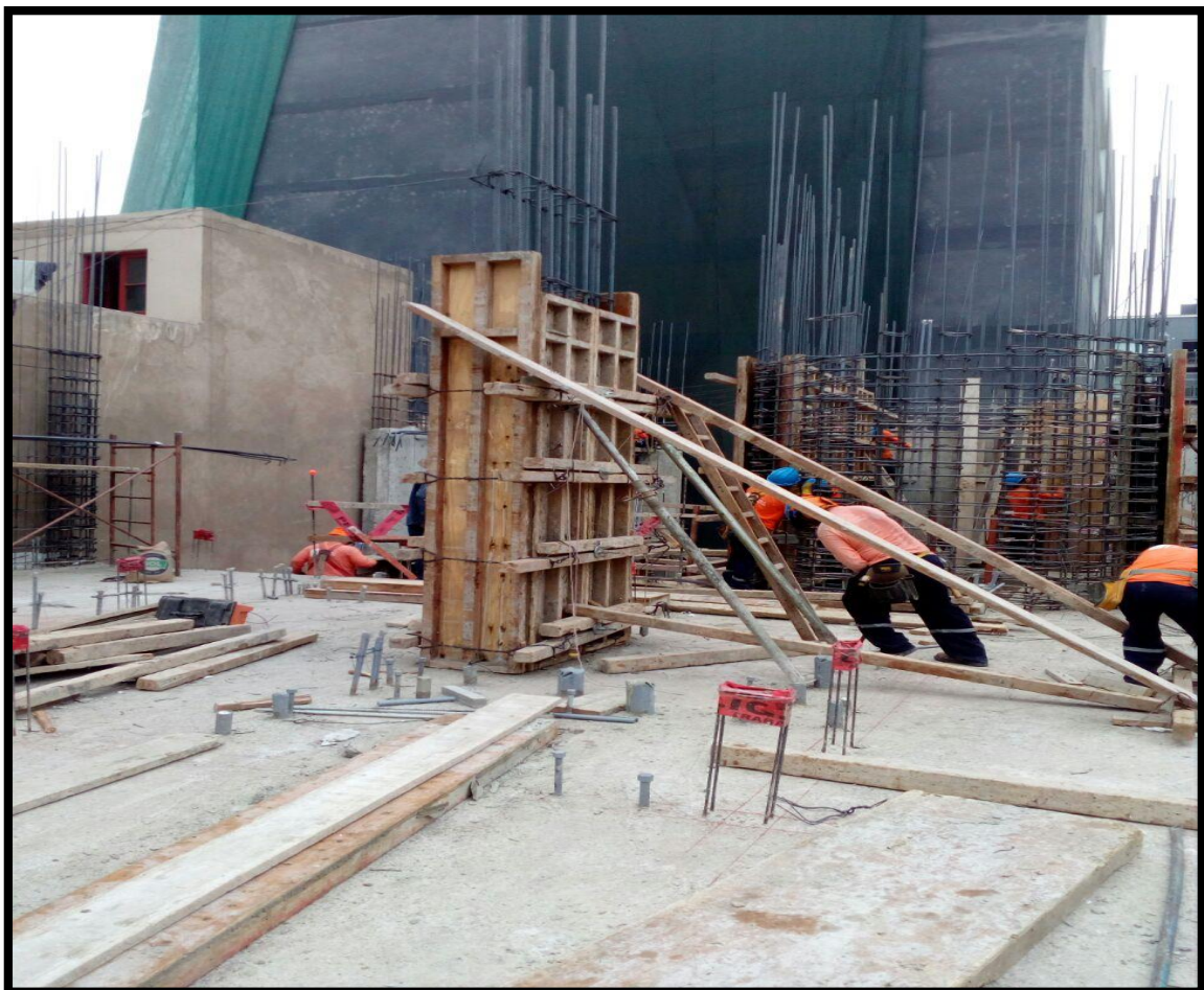
Figura 18. Encofrado en Placas. Fuente: Elaboración propia
