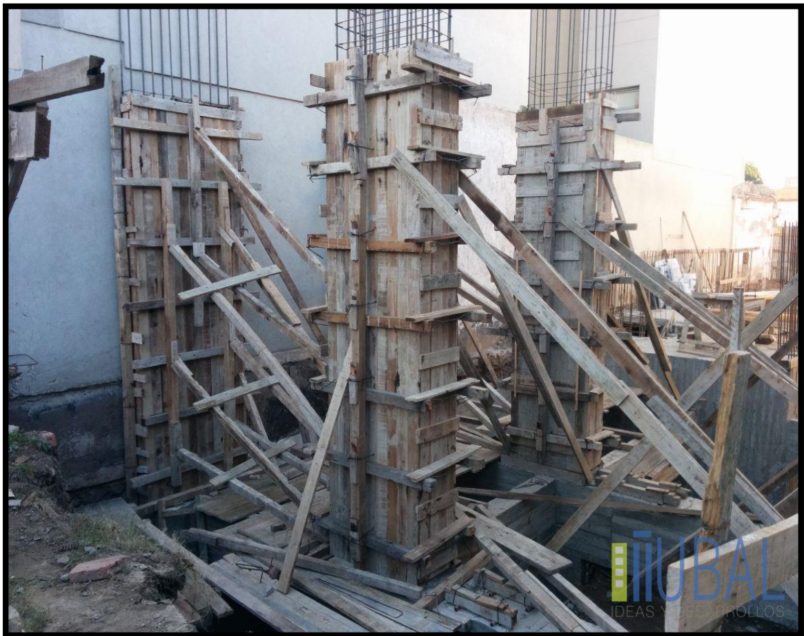
Figura 14. Encofrado de columna. Fuente: Elaboración propia
