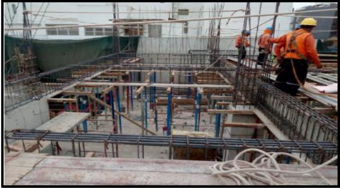
Figura 13. Armado de Viga aérea. Fuente: Elaboración propia
