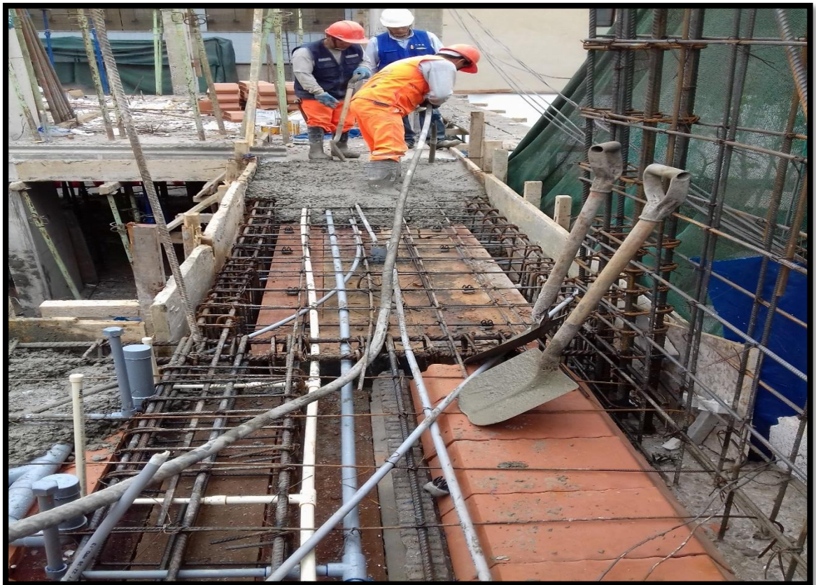
Figura 12. Vaciado de concreto en viga. Fuente: Elaboración propia
