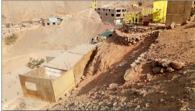
Figura 7. Vivienda en zona de riesgo, por taludes sin protección
