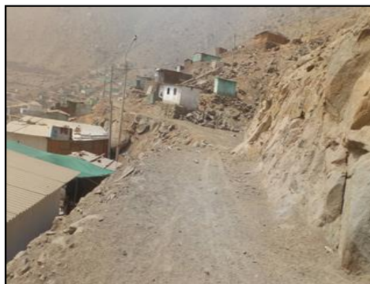
Figura (15). Talud Zona X
