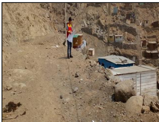
Figura (14). Talud Zona X
