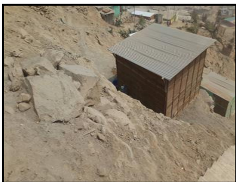
Figura (12). Talud Zona S
