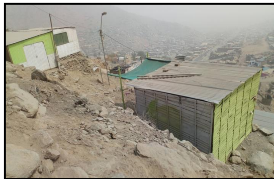
Figura (13). Talud Zona S
