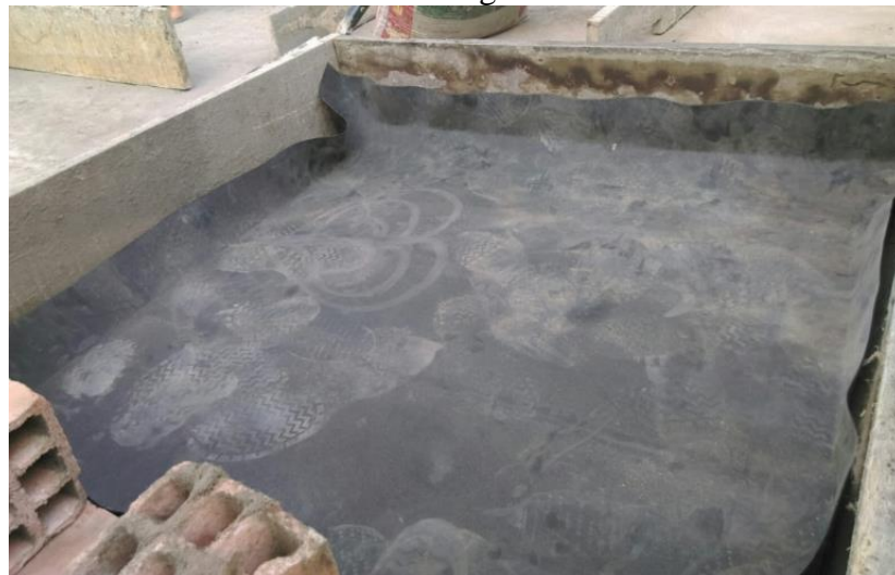
Gráfico 4: Instalación de geomembrana
