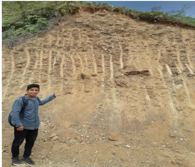
Foto 1. Vista perfil del talud
