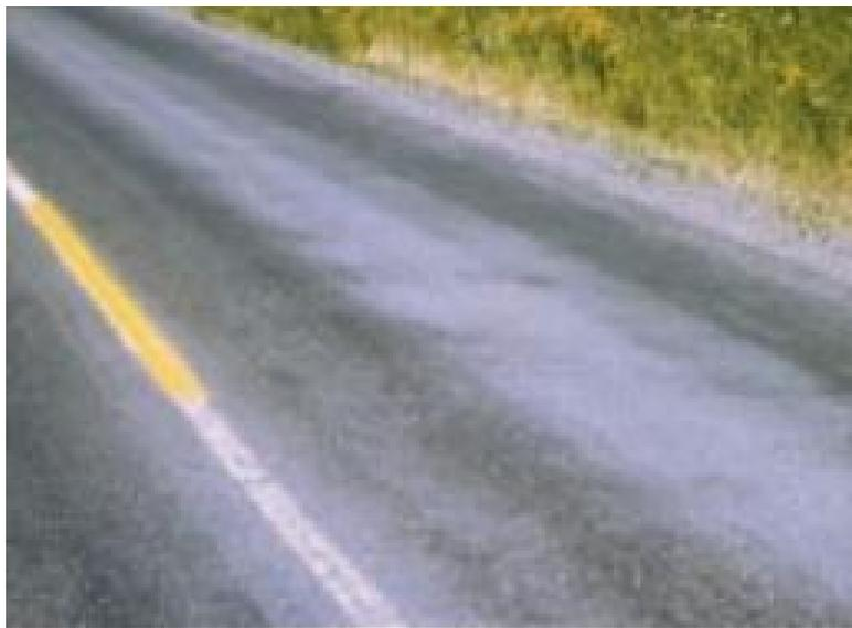
*Figura 4: Exudación. Fuente: Pavement Surface Condition Field Rating Manual for Asphalt Pavement. Washington State, 2013.*
