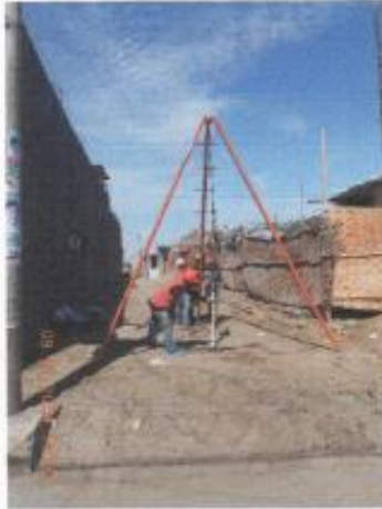
FOTO N°11.- Ensayos de SPT 03 en la zona del tanque reservorio a mejorar en el cercado de Sechura
