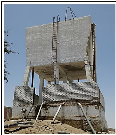
Figura 2. Reservorio elevado existente RE-02 de 230 m 3 de capacidad
