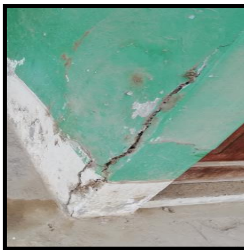
Figura 3.8. Muro del predio.
