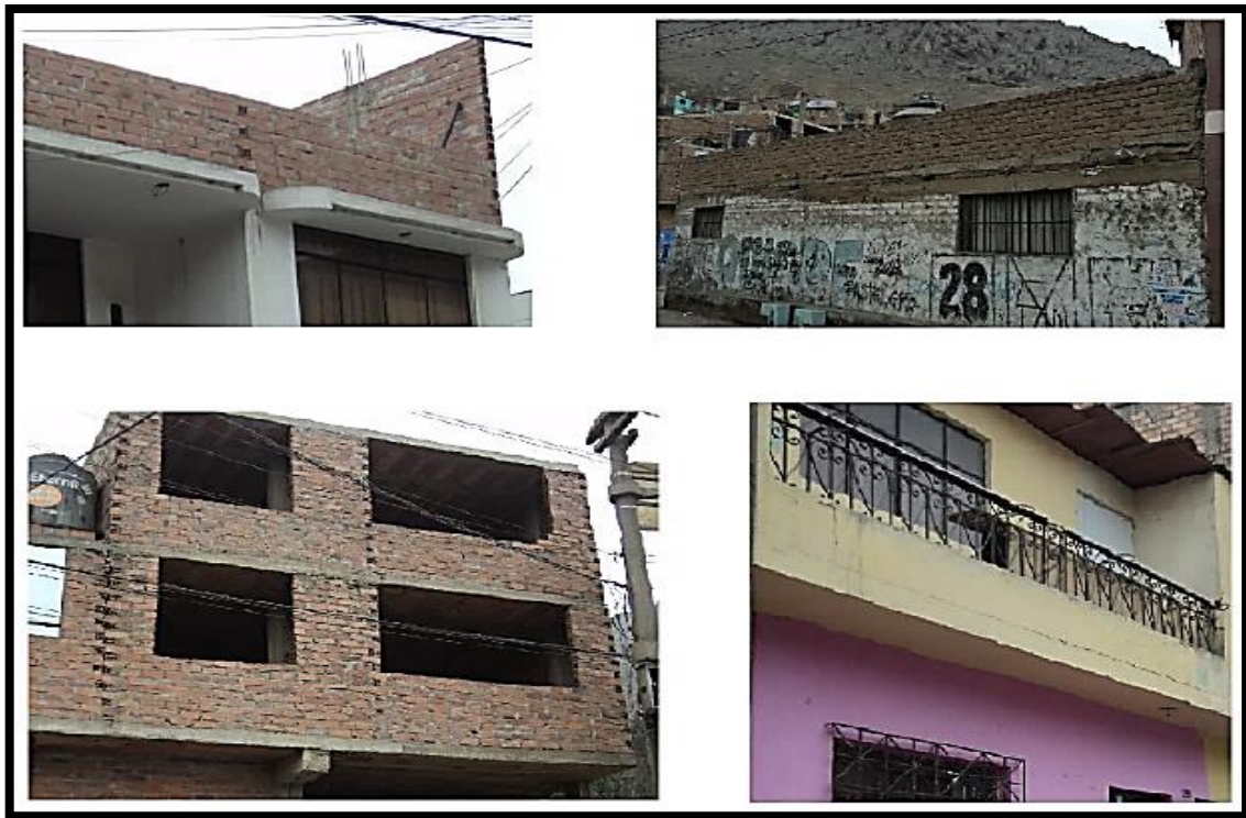
Figura 8.12. Ejemplo de elementos no estructurales.
