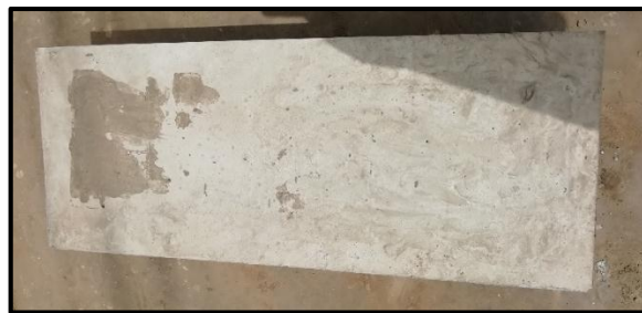
Figura 44: Reforzamiento con engrosamiento de concreto
