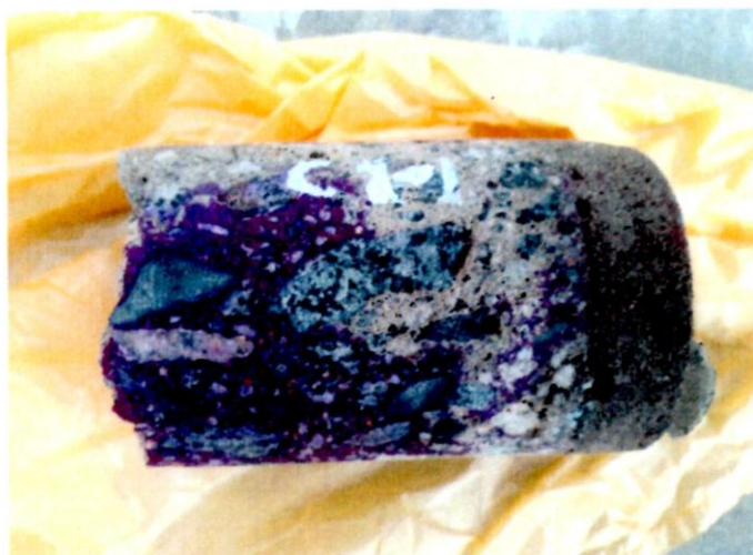
FOTO N°1: COLUMNA C -1 - 1 – PRIMER PISO
