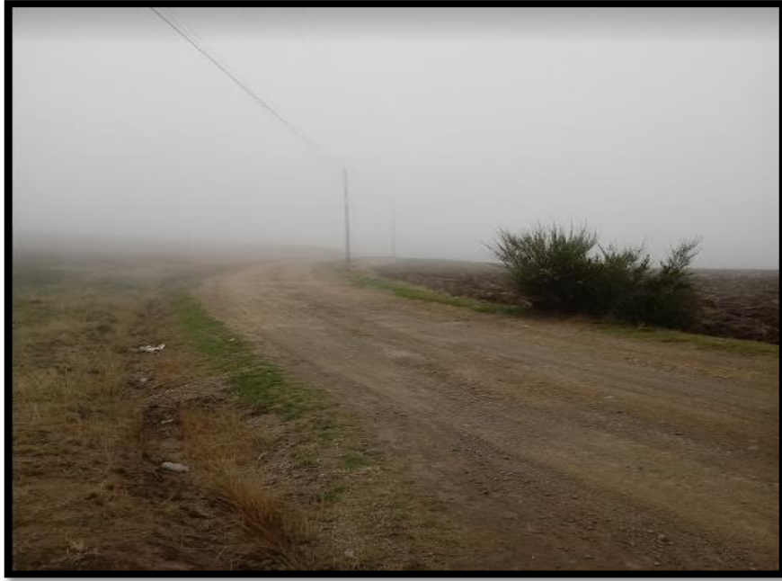
Figura 26. Estado actual de la carretera
