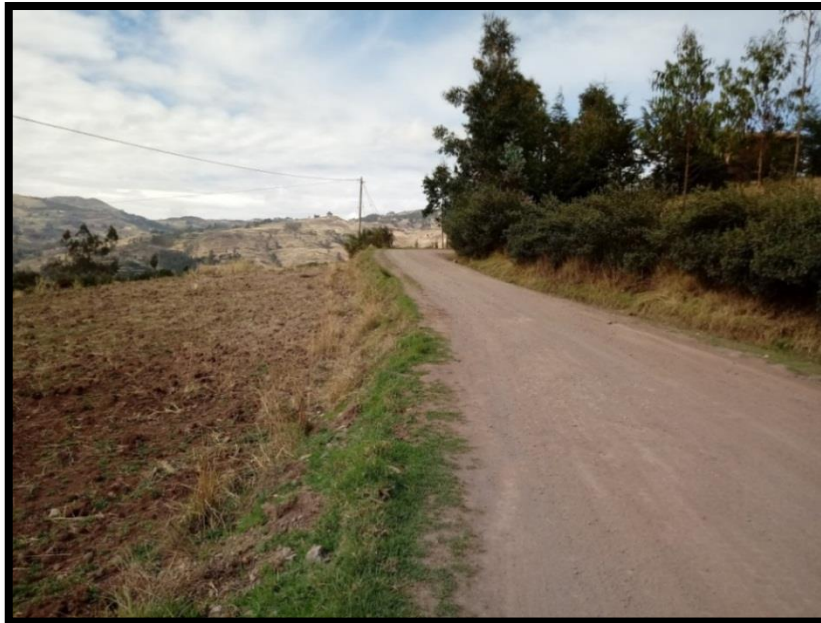
Figura 25. Estado actual de la carretera
