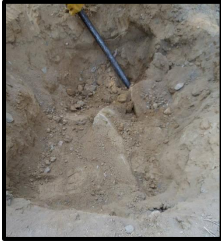
Foto 10: Calicata para el estudio de suelo
