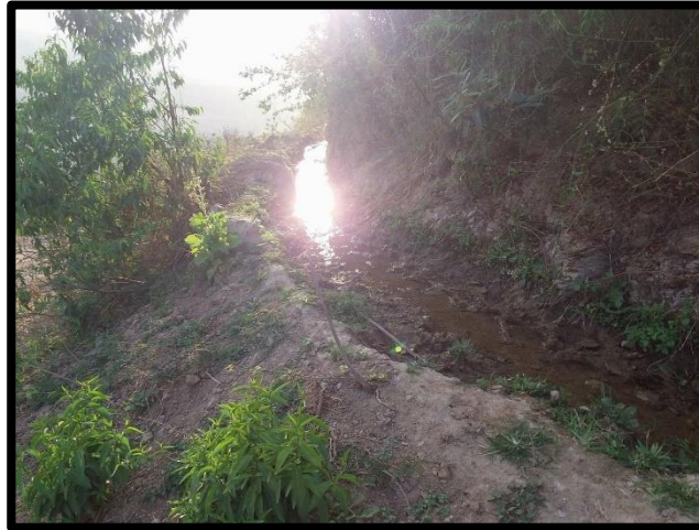
Foto 11: Aguas pluviales en zonas del tramo
