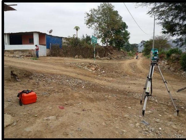
Foto 4: Punto de Inicio del Levantamiento Topográfico
