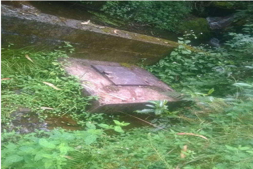
Foto 2: Captación existente "El Cristal"
