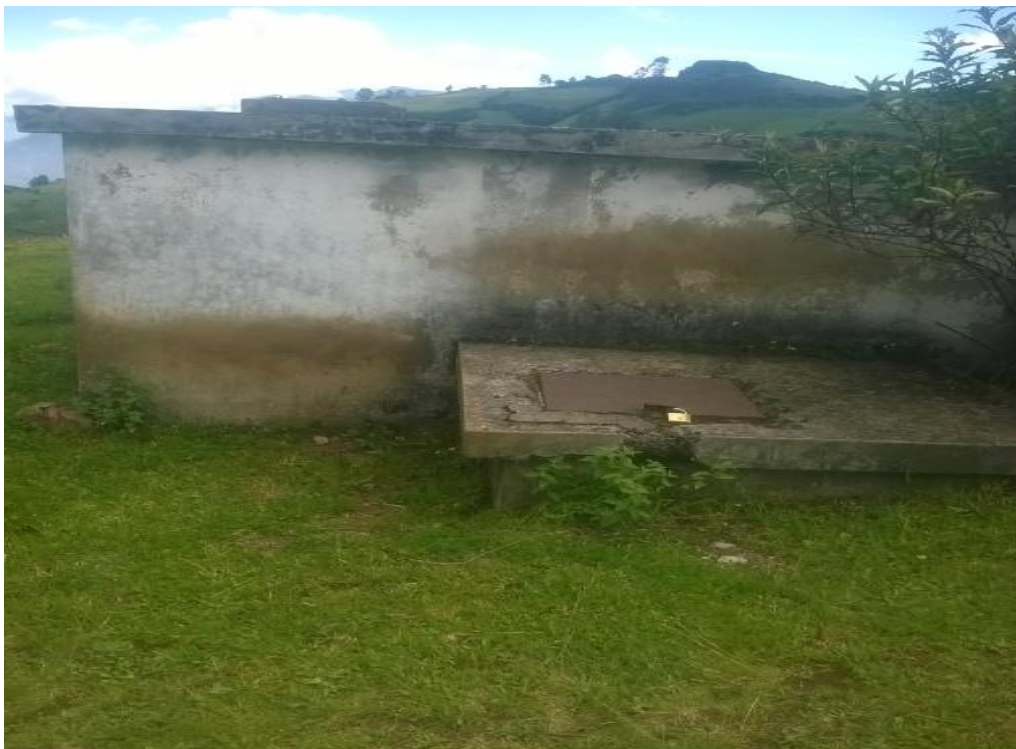
Foto 3: Reservorio existente (6 M3)
