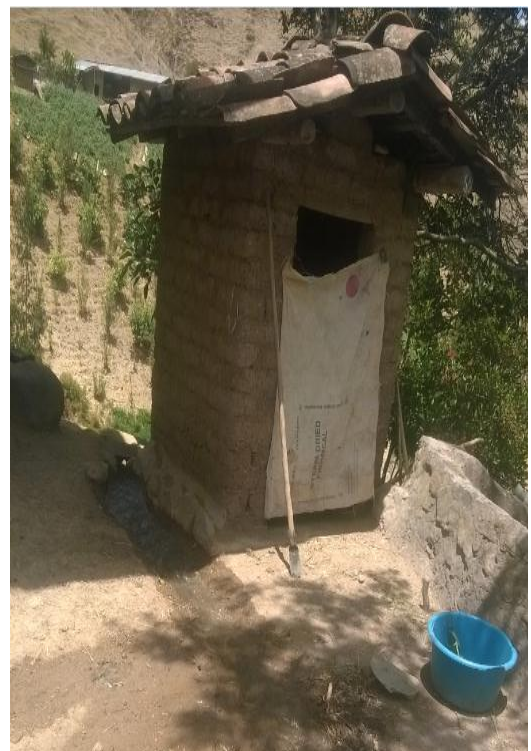
Foto 5: Sistema de saneamiento existente, Letrinas de pozo ciego
