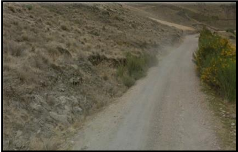
Figura 44. Vista de la carretera que varía entre 2.50m y 3.00m de ancho
