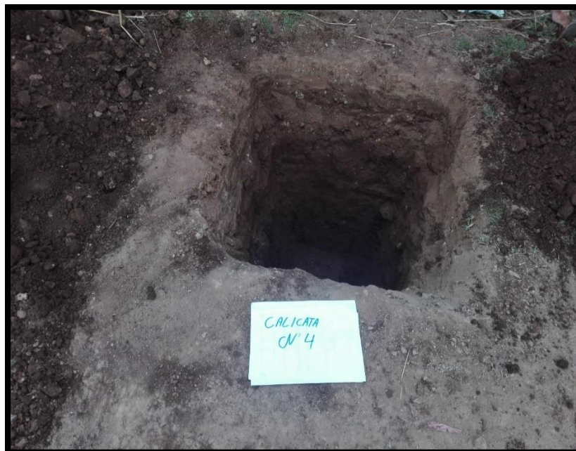
Figura 50. Elaboración de la calicata 4, para extraer muestras y ser llevadas al laboratorio de suelos.
