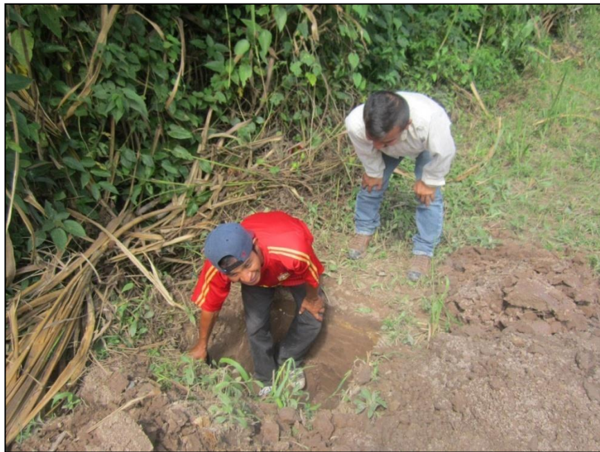
Figura 20. Supervisando la excavación de la calicata
