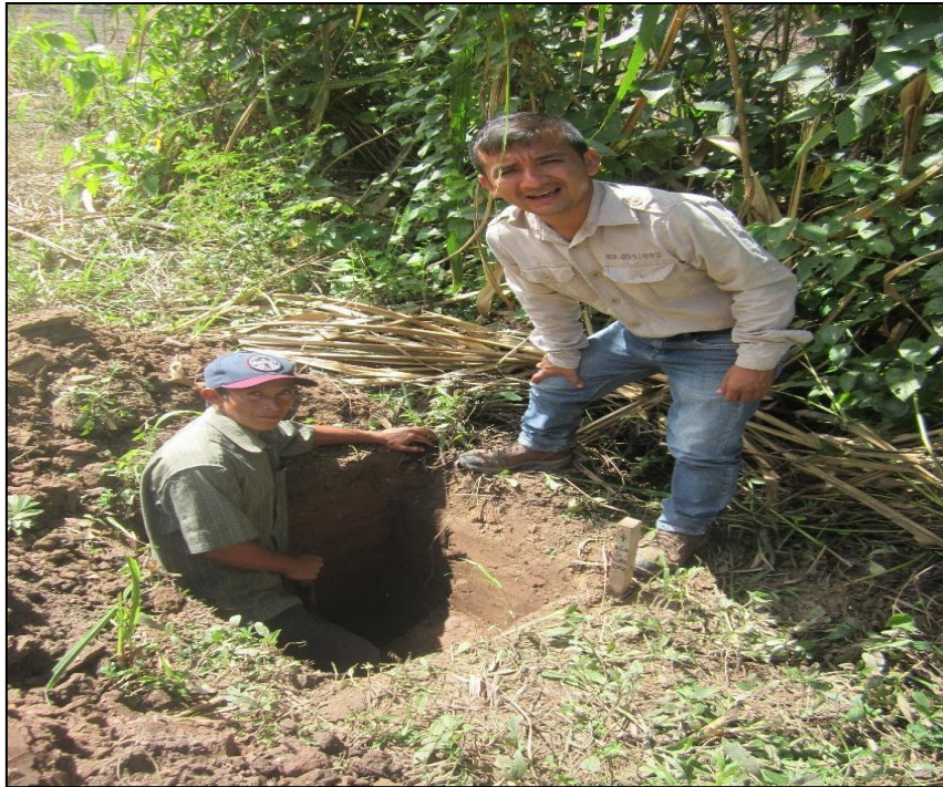
Figura 19. Supervisando la excavación de la calicata
