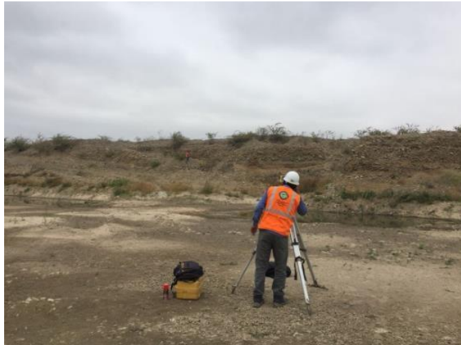
Fotografía 3. 1 Personal realizando el levantamiento topográfico
