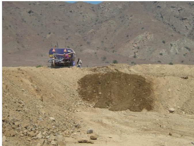
Fotografía 3. 2 Camión cisterna humedeciendo el terreno
