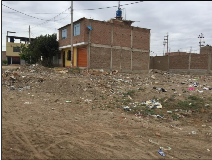
Figura 10. Zona identificada de acopio informal de RCD registrada como RCD_LAM_0006, con un volumen de 300.00 m 3 .
