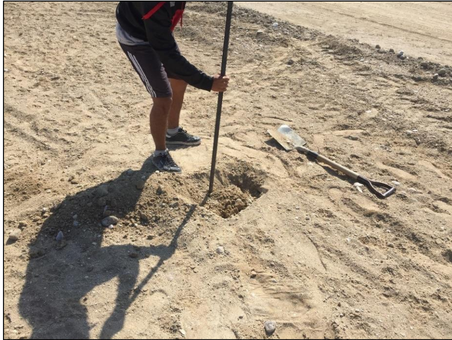
Figura 28. Proceso de excavación de la calicata C-01, de dimensiones 1.20x1.20m, con herramientas manuales.
