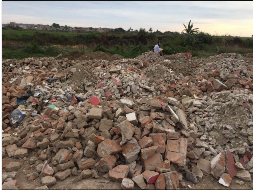
Figura 18. Zona identificada de acopio informal de RCD registrada como RCD_LAM_0021, con un volumen de 560.00 m 3 .
