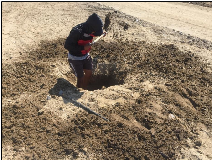
Figura 29. Proceso de excavación de la calicata C-01 hasta encontrar el nivel freático.
