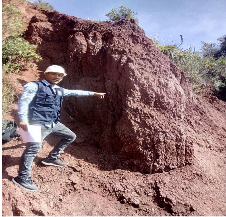
Figura 63. Inspeccion in-situ, fuente: elaboración propia, 2018
