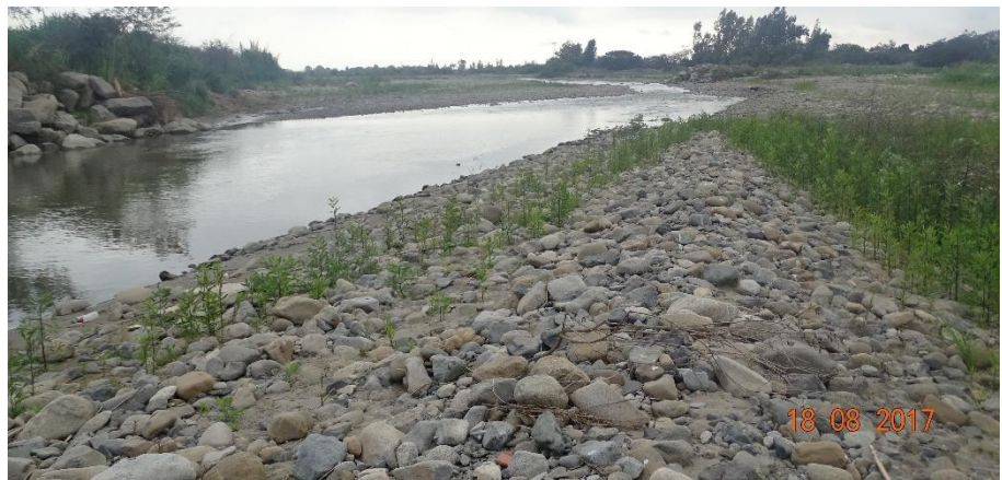
Figura 13 : Descripción del material encontrado en el cauce del río Virú Km 7+300 - Km 10+640
