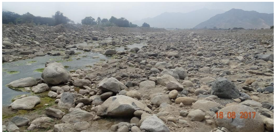
Figura 10 : Descripción del material encontrado en el cauce del río Virú Km 1+000 - Km 2+580
