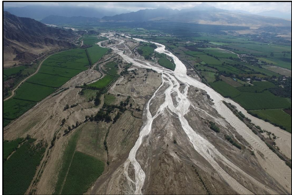
Fotografía 2 : Nivel de inundación del río Virú en el tramo aguas abajo del cruce del Badén - Virú
