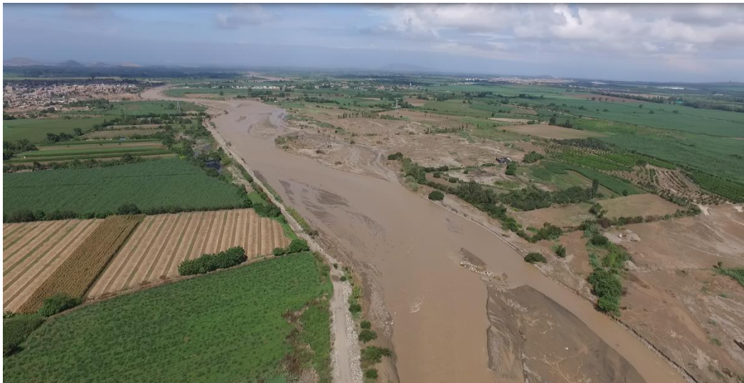
Imagen 7 : Otra Fotografía aérea capturada con Dron tramo Puente Alameda – Puente Virú.
