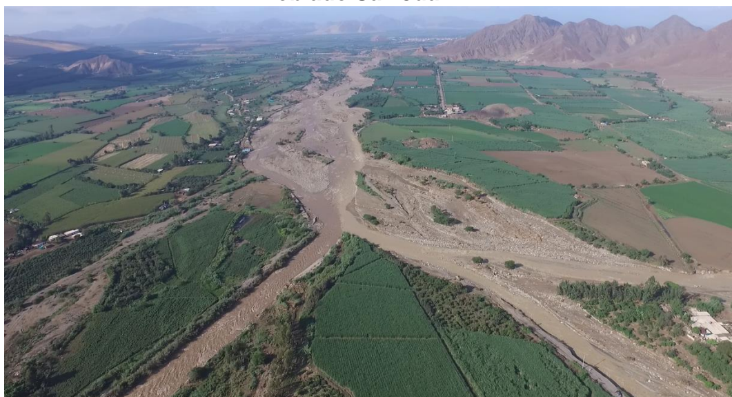
Imagen 1 : Fotografía aérea capturada con Dron tramo Zaraque – Centro Poblado San Juan.
