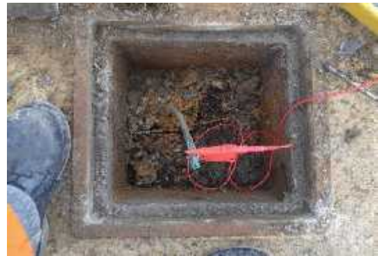
Fotografía De una caja de registro de una sub estación sin electrodo solamente un cable suelto.
