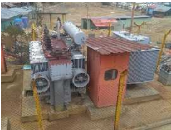
Fotografía De la sub estación de dos transformadores que se encuentra en las instalaciones de Quiruvilca en la zona de Morococha
