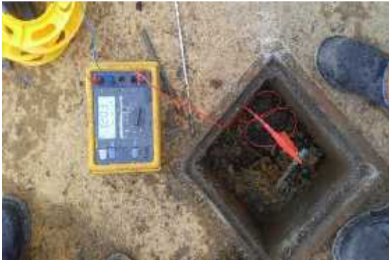
Fotografía De una caja de registro de una sub estación sin electrodo solamente un cable suelto.
