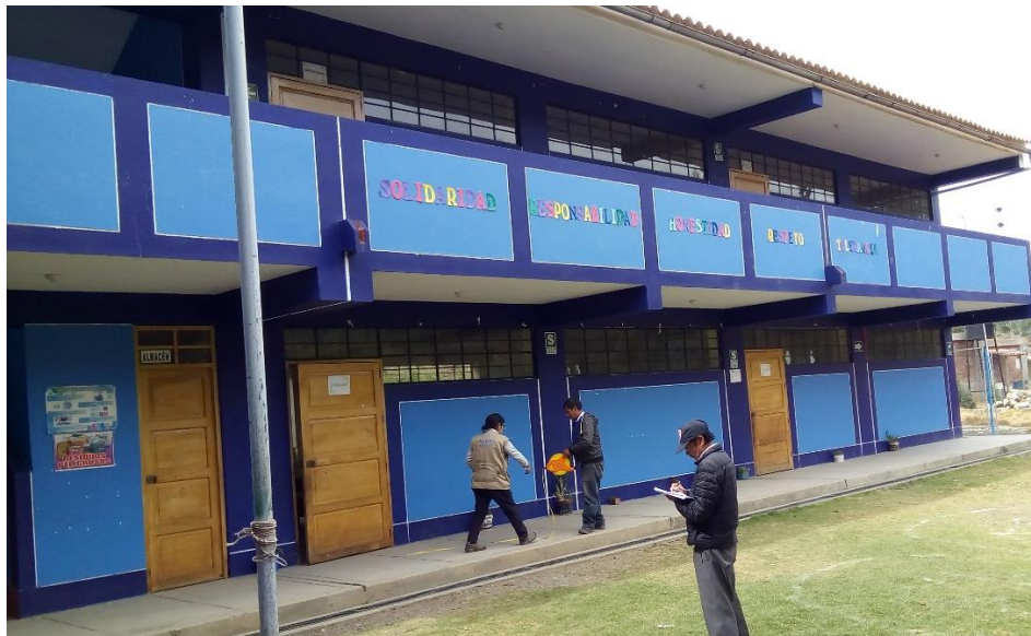
FOTO N° 13: MEDICIÓN DE LA FACHADA DEL BLOQUE DE LA I.E.E. DE COYLLUR
