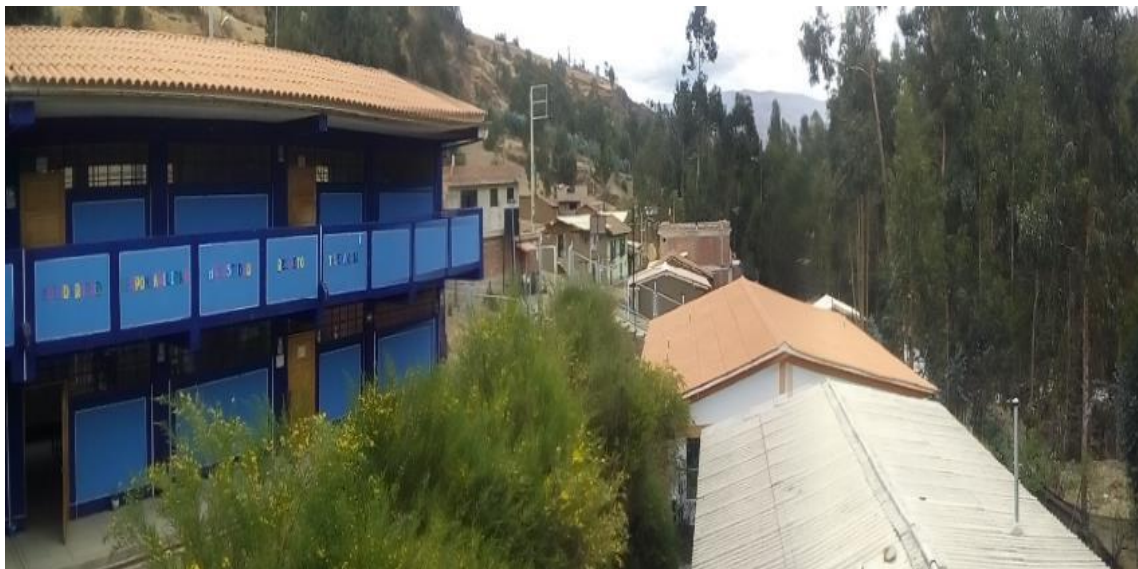
FOTO N° 06: TECHOS DE LA I.E.E. DE COYLLUR
