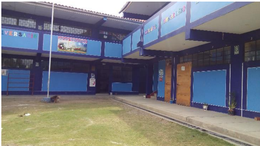
FOTO N° 05: PABELLO N° 02 Y 03 DE LA I.E.E. DE COYLLUR
