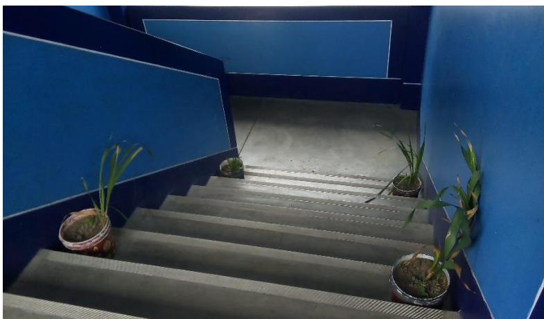
FOTO N° 09: ESCALERA DE LA I.E.E. DE COYLLUR
