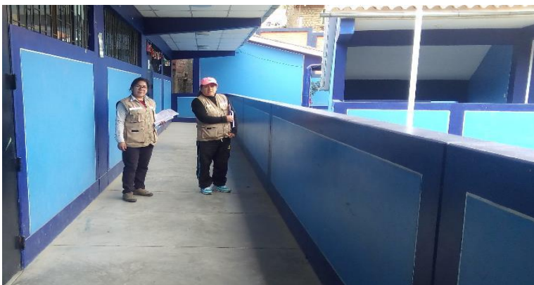
FOTO N° 08: PASADISOS Y ALEROS DEL SEGUNDO PISO DE LA I.E.E. DE COYLLUR
