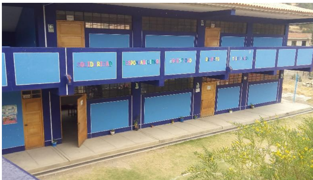
FOTO N° 02: BLOQUE N° 02 DE LA I.E.E. DE COYLLUR
