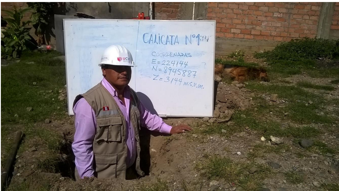
Imagen 8: colocacion de coordenadas en el punto de trabajo.
