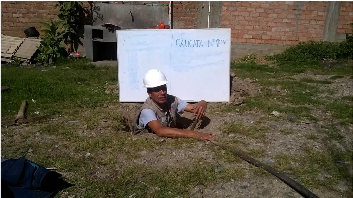
Imagen 5: completando la profundidad para toma de muestra.
