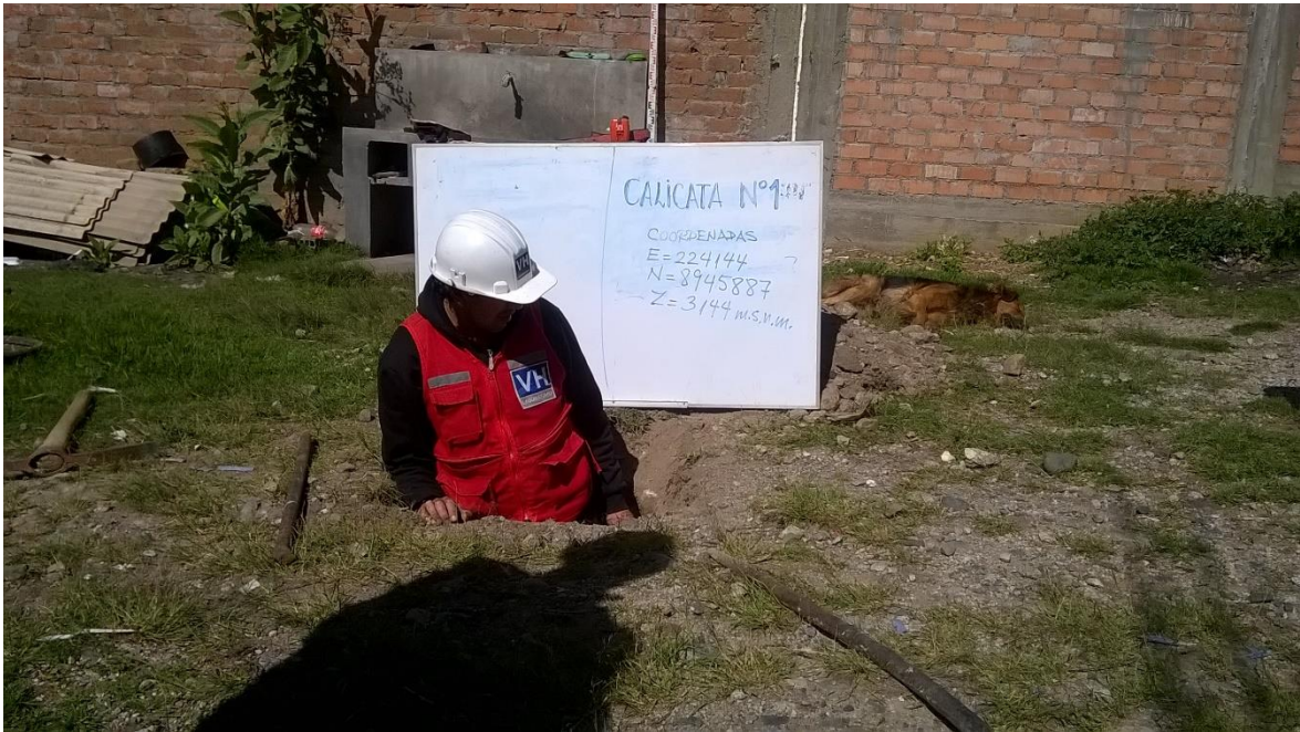
Imagen 7: personal de laboratorio de suelos supervisando.
