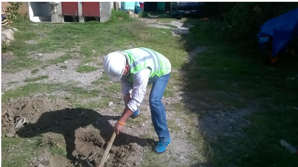
Imagen 4: procedimiento de la excavación en el punto de ubicación.
