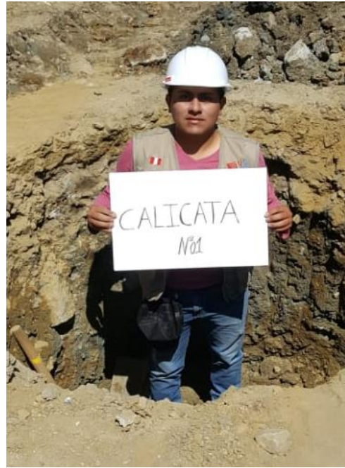
Figura 36. Excavacion de la calicata 01
