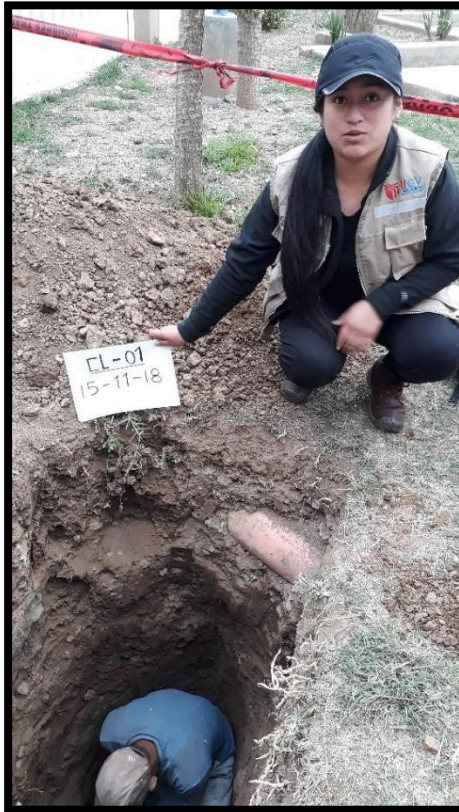
Imagen 3: Excavación de calicata.
