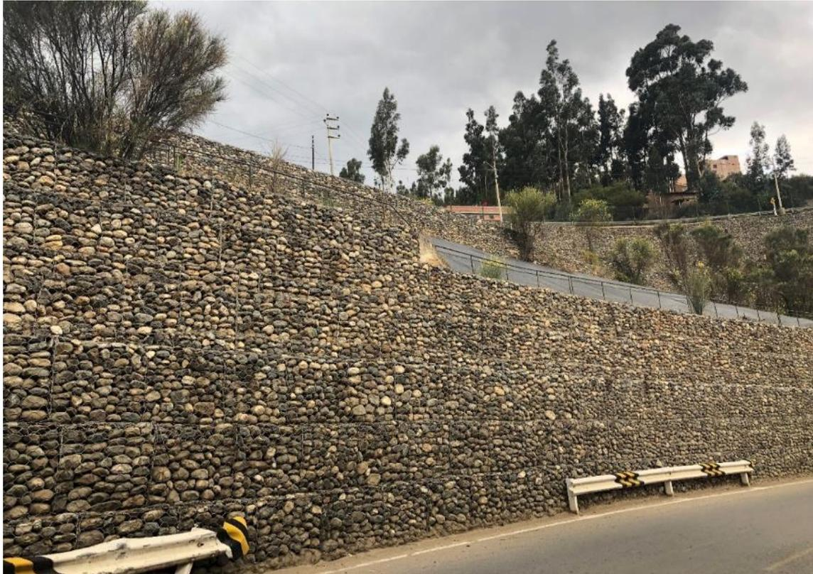
FOTO N° 19 PRESENCIA DE GAVIONES ENTRE LA PLATAFORMA Y EL TALUD
