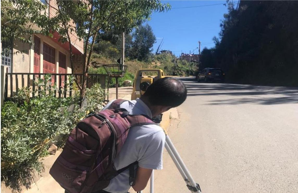
FOTO N° 11 INTALACIÓN Y NIVELACIÓN DEL ESTACIÓN TOTAL
