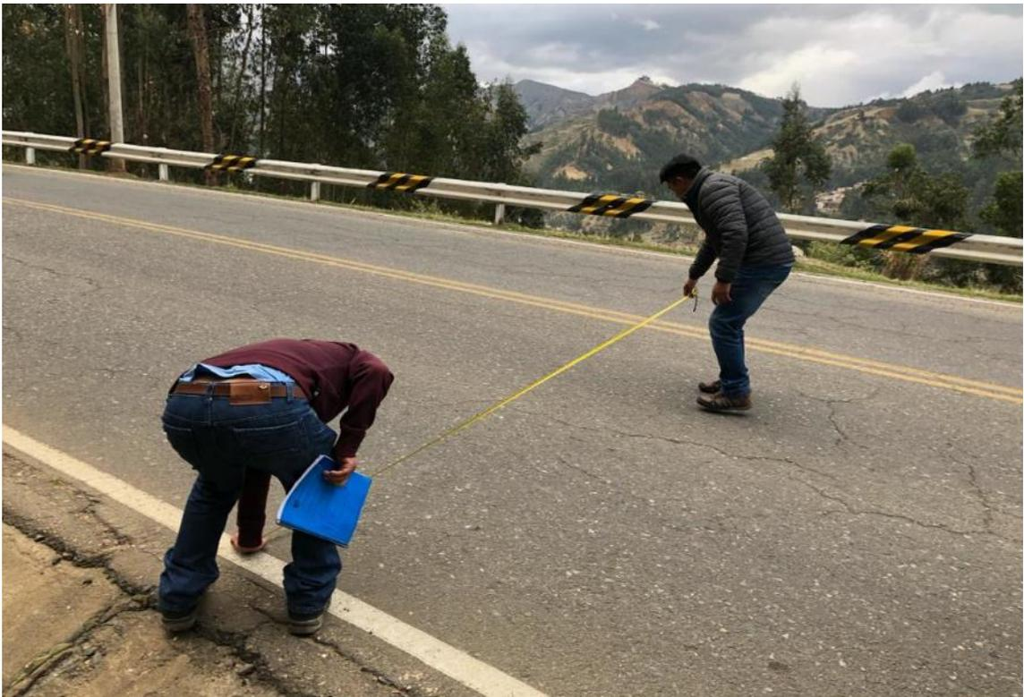
FOTO N°36 REALIZANDO LA MEDICION DE LA CALZADA
