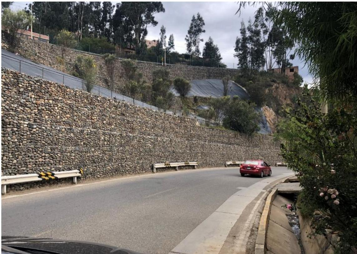
FOTO N° 18 VISTA FRONTAL DE GAVIONES Y DE GEOMEMBRANAS
