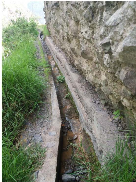
“TALUDES DE CORTE DEL CANAL DE MATUCANA”
