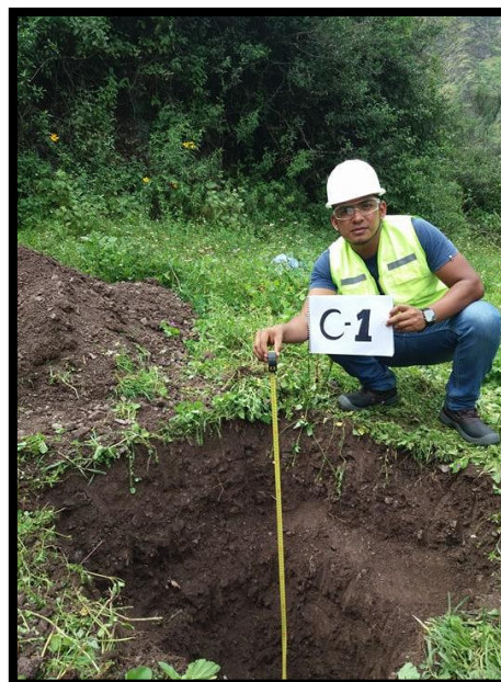
Fig. A1 – Excavación de calicata N° 1
