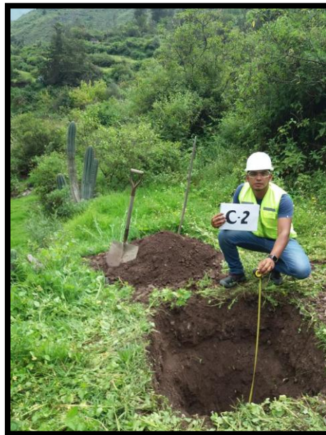
Fig. B1 – Excavación de calicata N° 2
