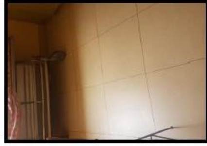
PISO DE CERAMICA
