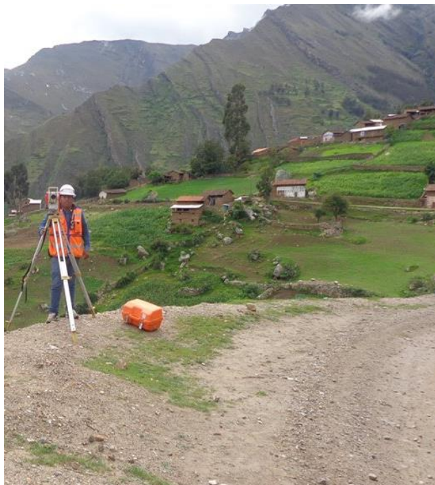
Fotografía 2. Levantamiento topográfico en la parte sur de Lucma
