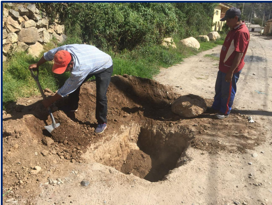
Fotografía 10: Devolución de la tierra después de extraer las muestras.
