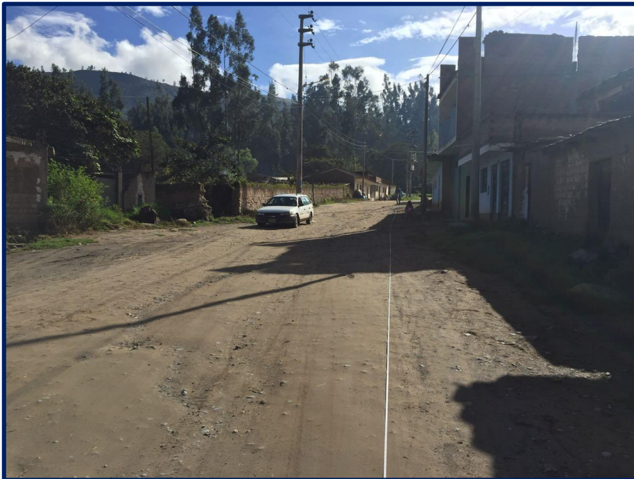
Fotografía 2: Medición del tramo en estudio.
